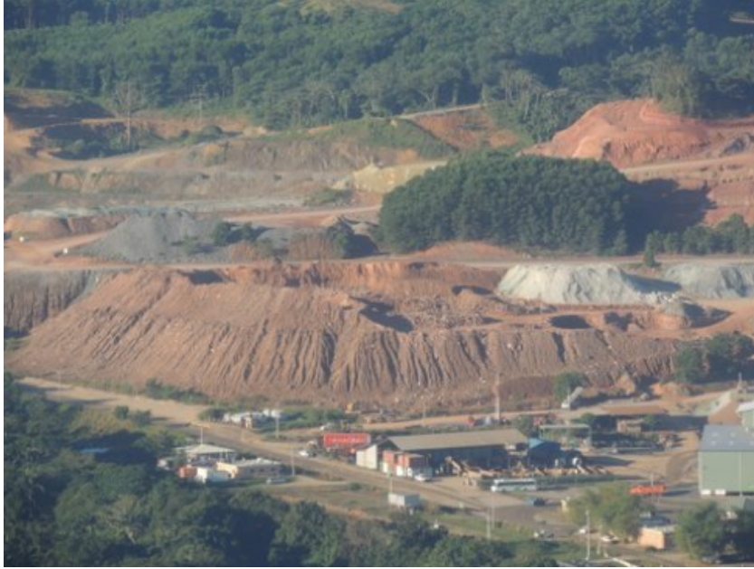
Figura 5 - Evidencia de erosión en vertederos.
