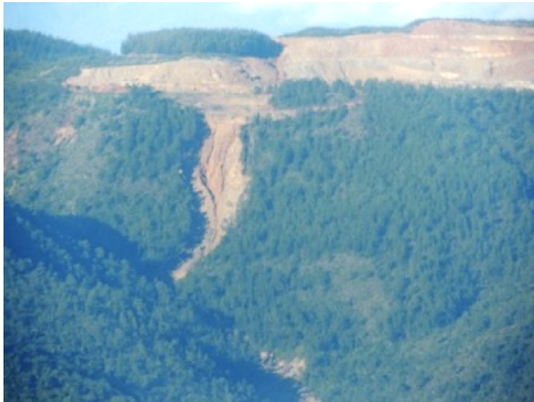
Figura 3 - trabajos actuales que muestran la erosión (cortesía R. Negret).
