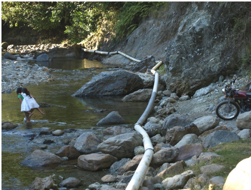
Foto 3: Captación de agua potable para la comunidad El Algarrobo, aguas abajo de La Llovedora.
