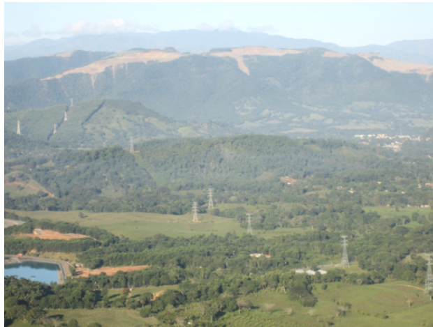
Figura 2 - Vista de los trabajos de las antiguas lateritas de níquel.
