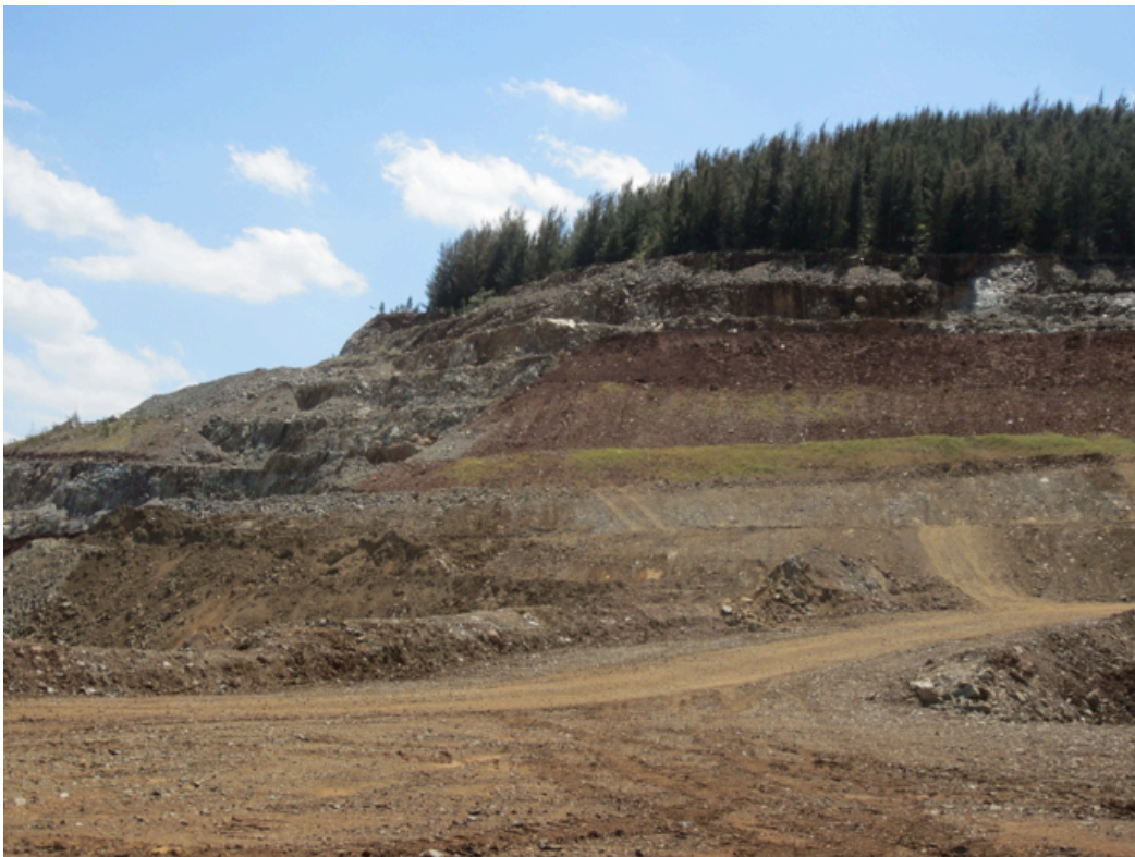
Figura 4 - Etapas de la rehabilitación de la mina de Loma Ortega.
