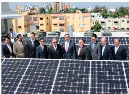
Figura 6: Vista del sistema fotovoltaico de la CNE, con 88 paneles y capacidad instalada de 22,000 Wp para un ahorro de un 25% de su consumo interno de electricidad al año y reducción esperada de 655 toneladas de emisiones de CO 2 . Fuente: http://www.cne.gov.do
