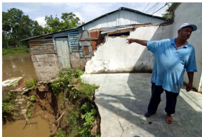
FOTO 5. INUNDACIONES Y SOCAVAMIENTO ASOCIADAS CON LAS TORMENTAS NOEL Y OLGA, PROVINCIA SAN CRISTÓBAL. (JUAN CARLOS ORREGO 2007).
