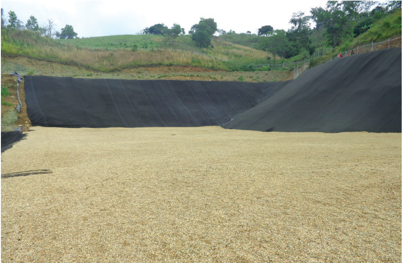
Construcción del vertedero controlao de Villa Altigracia
