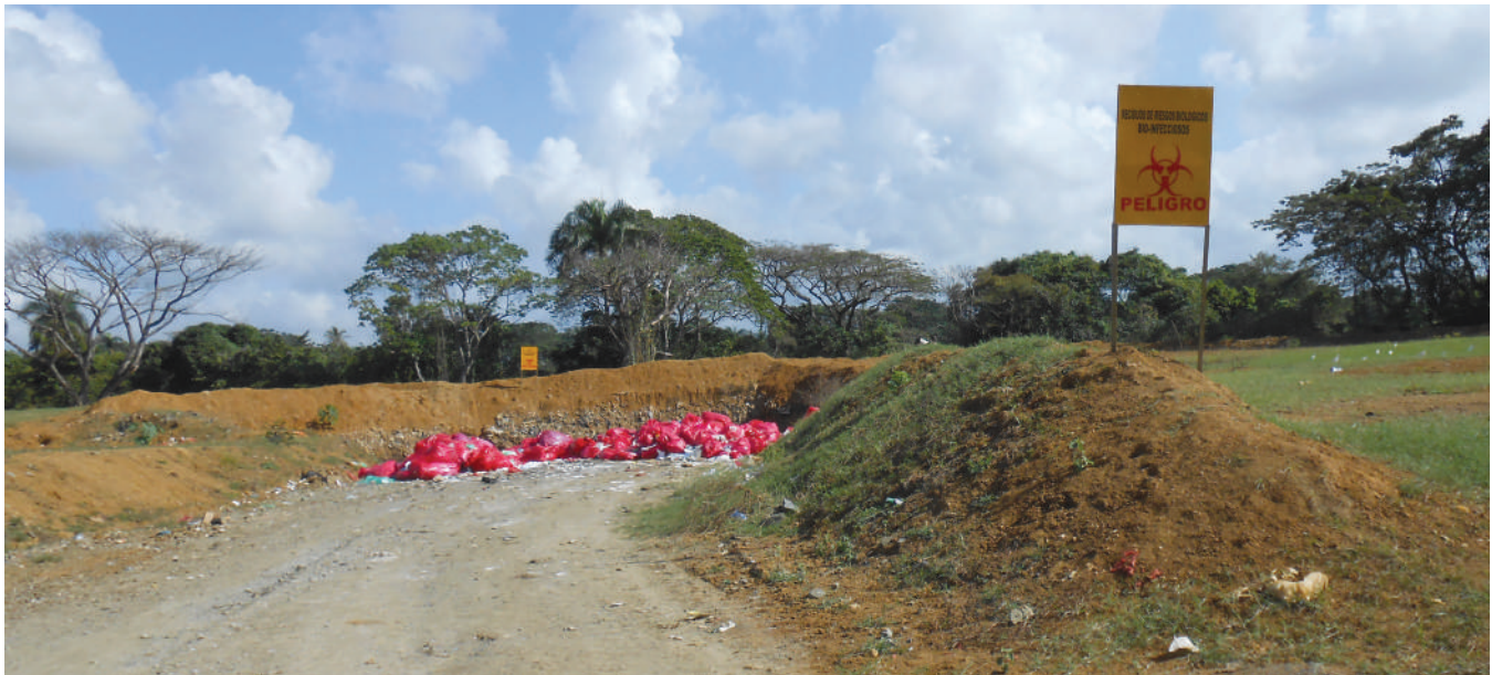
Tratamiento de residuos peligrosos en celda separada en el vertedero de La Vega.
