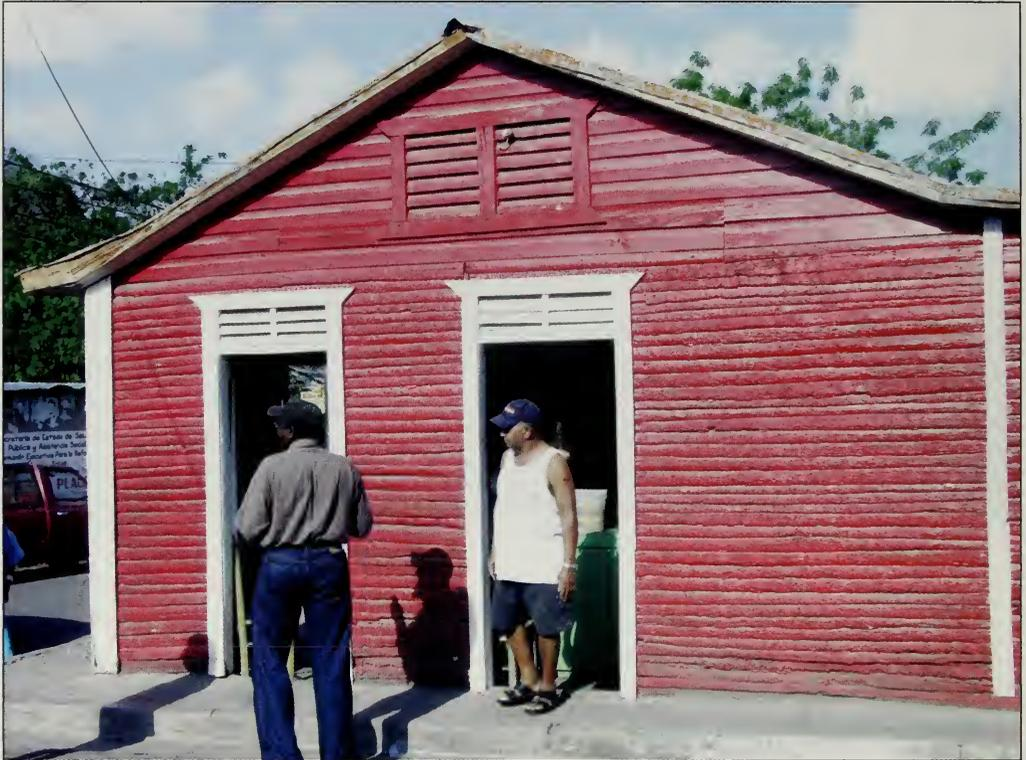
Fig. 4. Vivienda construida con madera de *Copernicia berteriana* en el pueblo de Azua.
