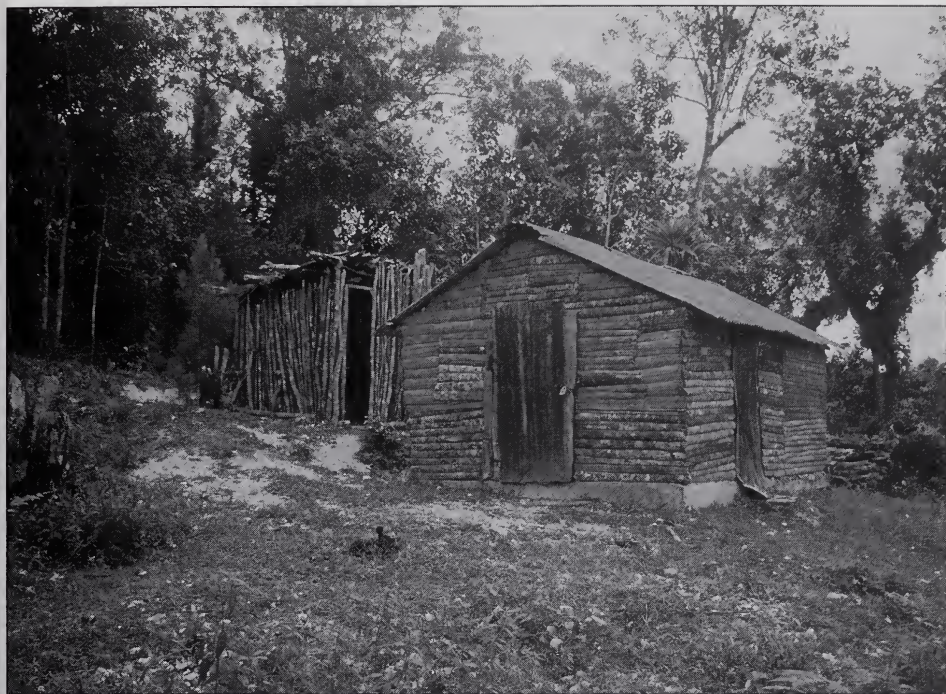
Vivienda típica en El Cachote, construida con materiales provenientes del bosque circundante.
