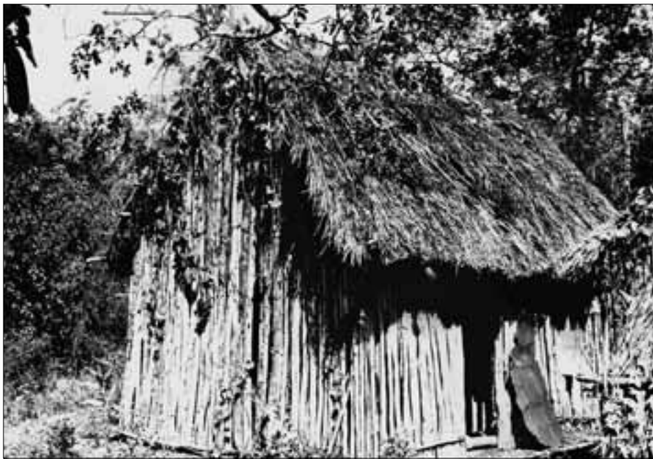
Bohío en medio del bosque, no lejos de Guaraguao, levantado con varas verticales que no protegen ni del viento ni de la lluvia.
