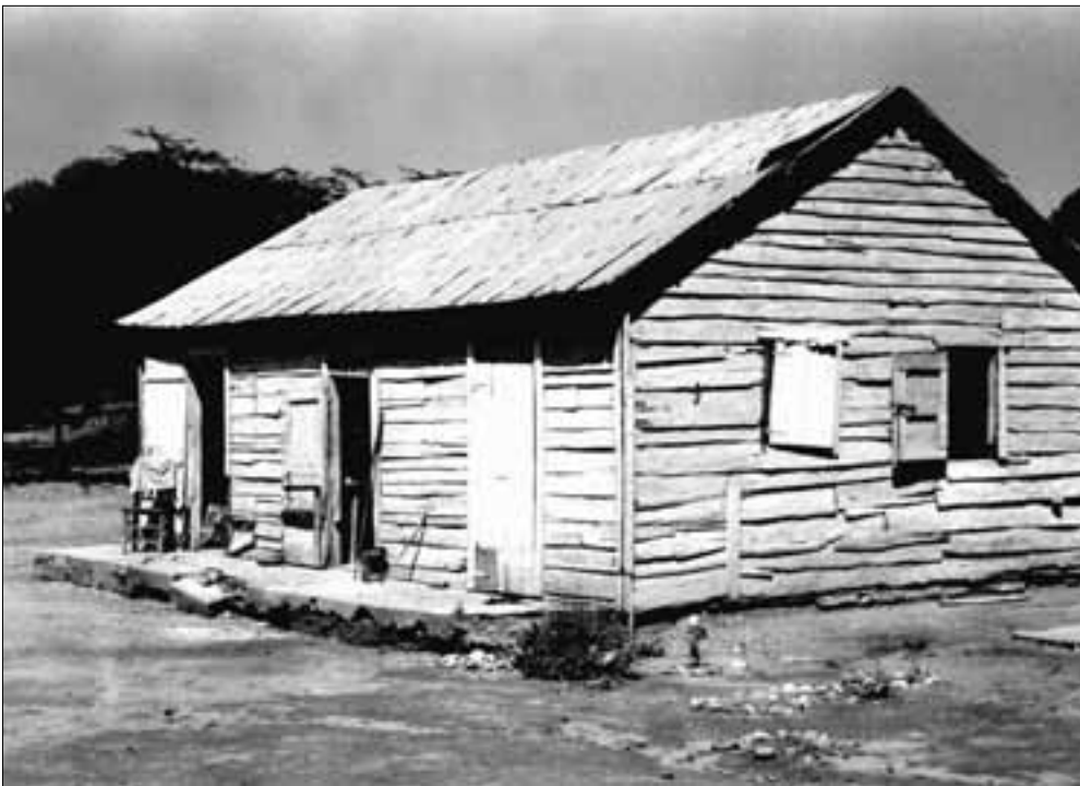
(Foto sup.) Bohíos junto al puente de Bocaina, en la orilla alta del Nizao, en el ramal sureño de la cordillera Central.
