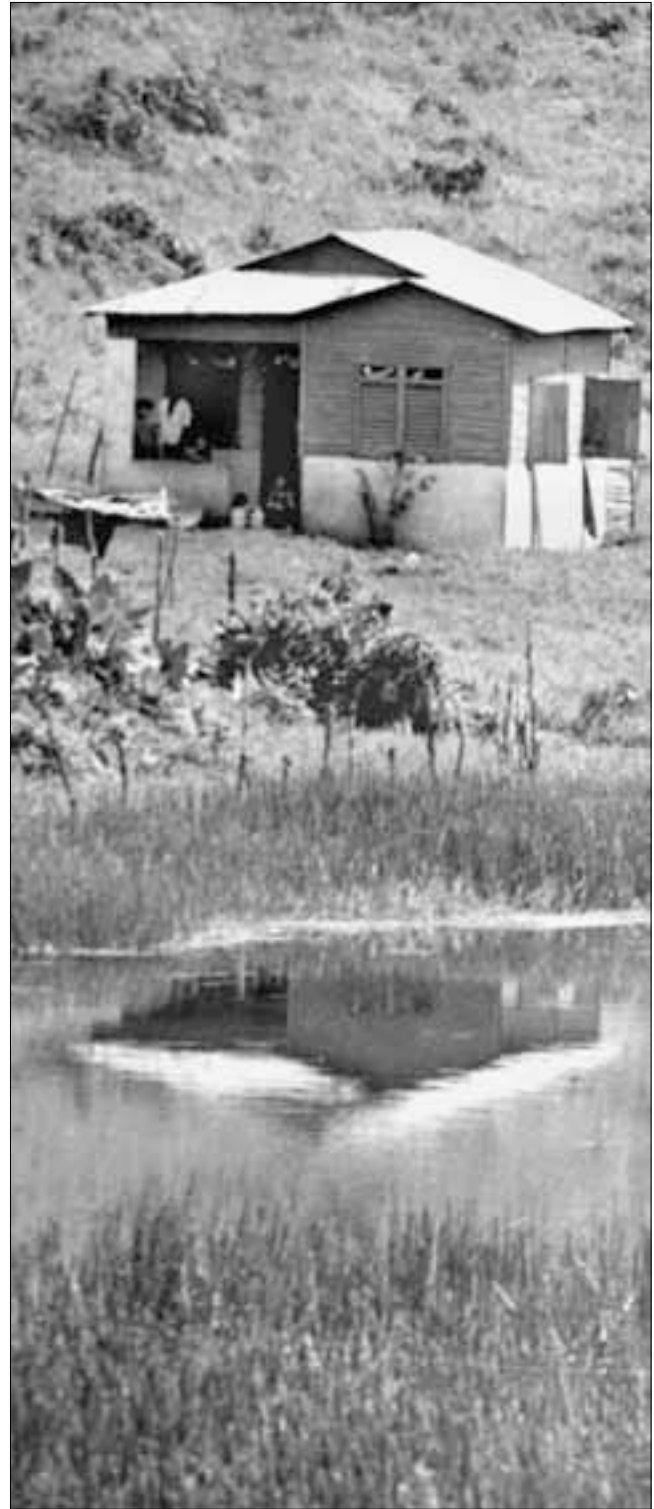
La laguna refleja una casa yunera con zócalo de cemento que la protege de las frecuentes inundaciones del río Yuna.
