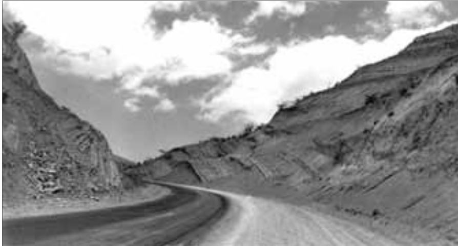
(Foto sup.) Estratos verticalizados de la formación Trinchera en losas de la sierra de Neiba por donde pasa la nueva carretera de Azua a Barahona.
