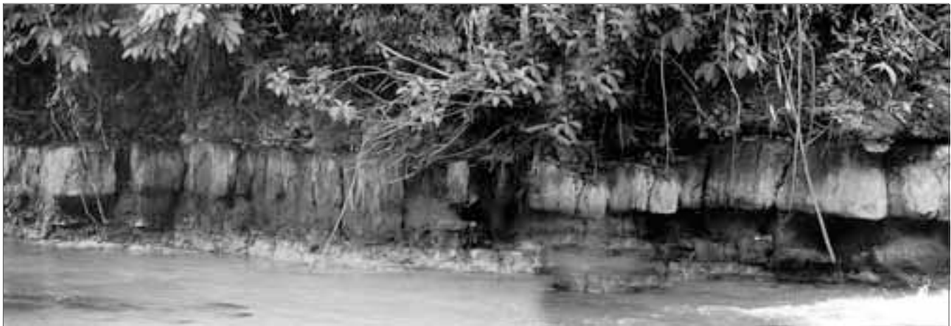
Puntas de rocas que salen del barranco junto al salto del Yanigua y que son restos de las distintas etapas en el retroceso del escalón del salto.
