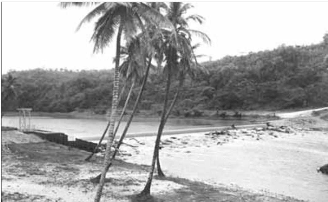
El agua del mar entra hasta aquí por la ría del Chavón. La pequeña presa impide que suba hasta la toma del acueducto de La Romana.
