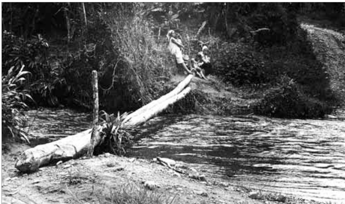
Río La Descubierta, con el típico puente de palos. Los plátanos que ya llegan a la orilla indican que el bosque de galería que protegía sus márgenes, ha sido destruído. En la margen derecha del río, campesinas con sus hijos, en espera de nada.
