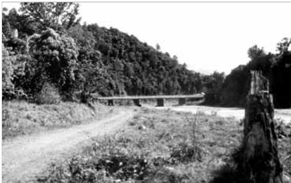
(Foto sup.) Puente sobre el río Nizao, en Las Avispas, donde el camino y el río parecen confluir.
