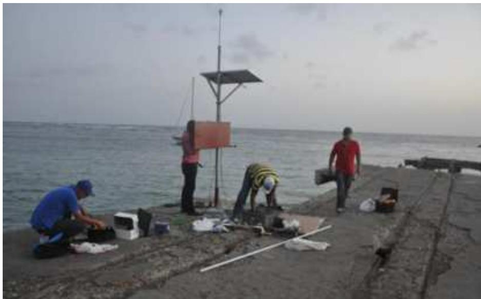
**Foto 4-25. Proceso de colocación del mareógrafo en el muelle de Palenque por parte de INDEMAR.**
