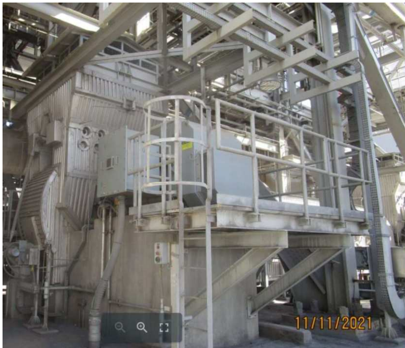
Figura 3-8 — Ventiladores PA
