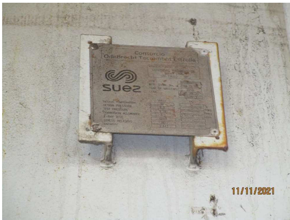
Figura 3-41 — Placa de identificación de los Recipientes de Filtros
