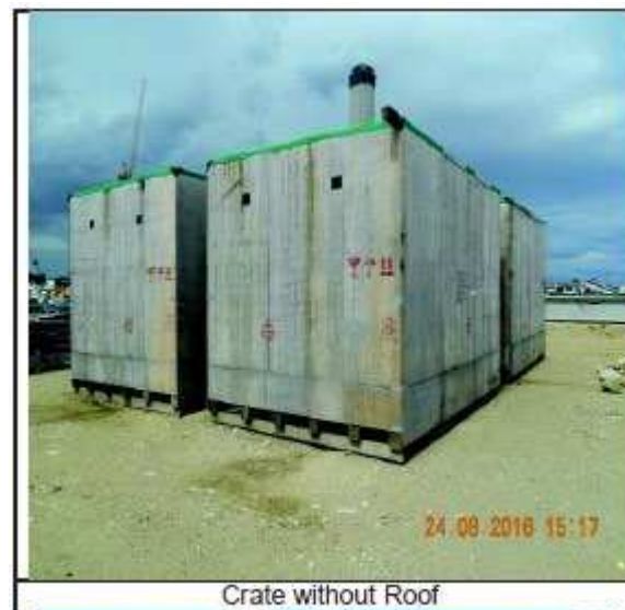
Figura 3-14 — Motores grandes almacenados incorrectamente
