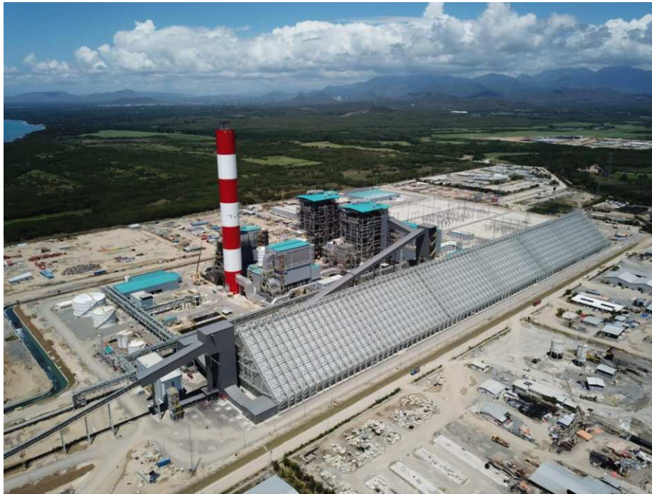
Figura 1-1 — Vista aérea de la Central Punta Catalina
