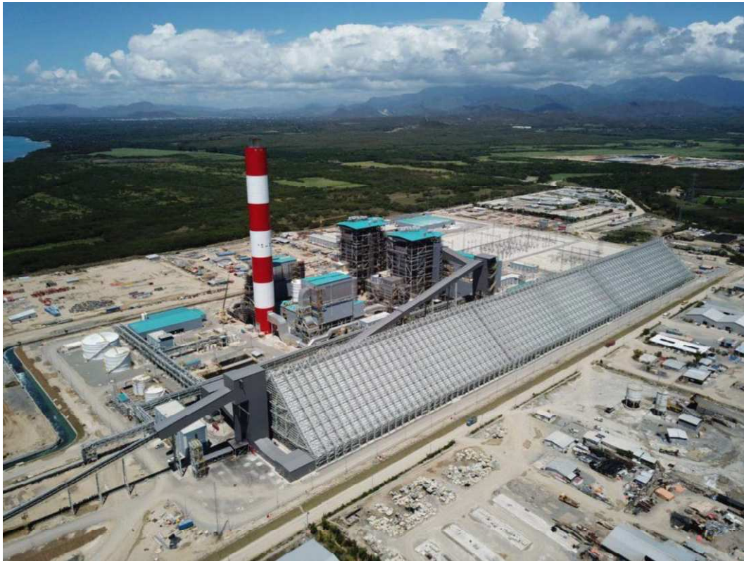
Figura 1-1 — Vista de la Central Punta Catalina
