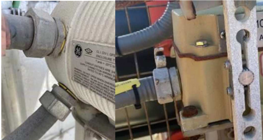
Figura 3-42 — Transmisor de Flujo AQCS e Interruptor de Límite de Manejo de Carbón con Juntas Seltas
