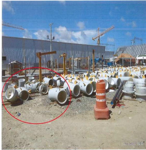
Figura 3-1 — Almacenamiento de tuberías con baldosas de cerámica
