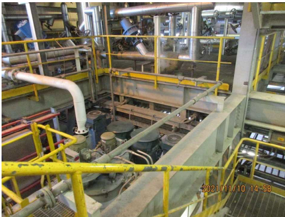
Figura 3-37 — Sistema FP, Tope Tanque ST LO
