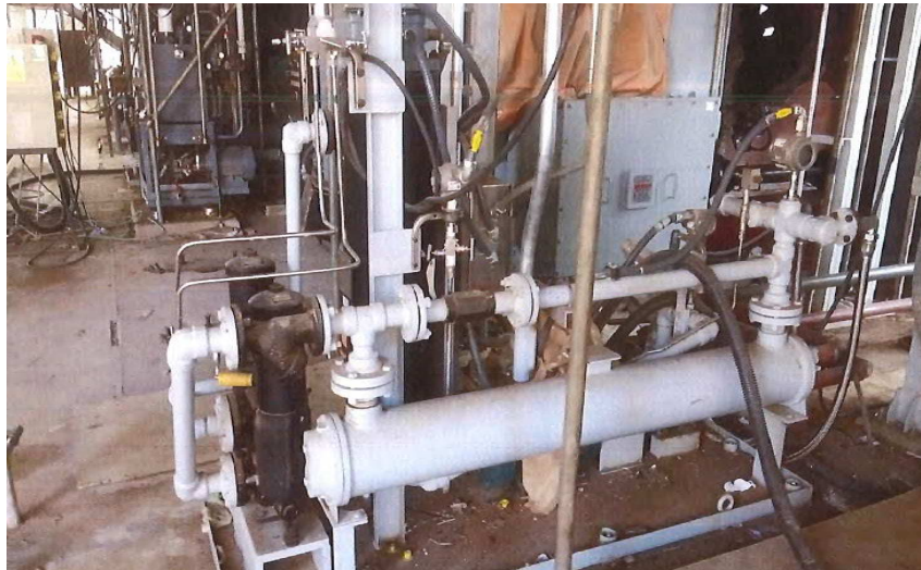
Figura 3-6 — Sistema de aceite pulverizador – Basura de construcción
