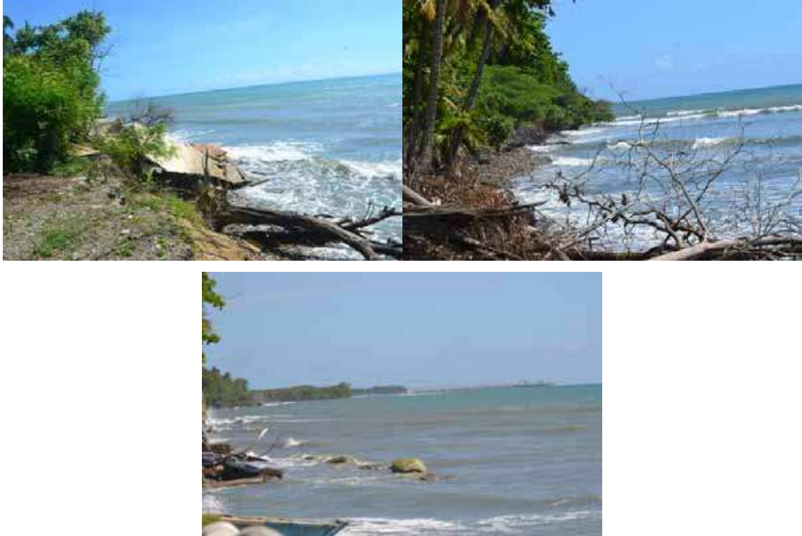
Figura 5. Fotografías del Litoral Oeste. Playa de Sabana Uvero, Paya, hasta la construcción del muro o dique de la CTPC.
