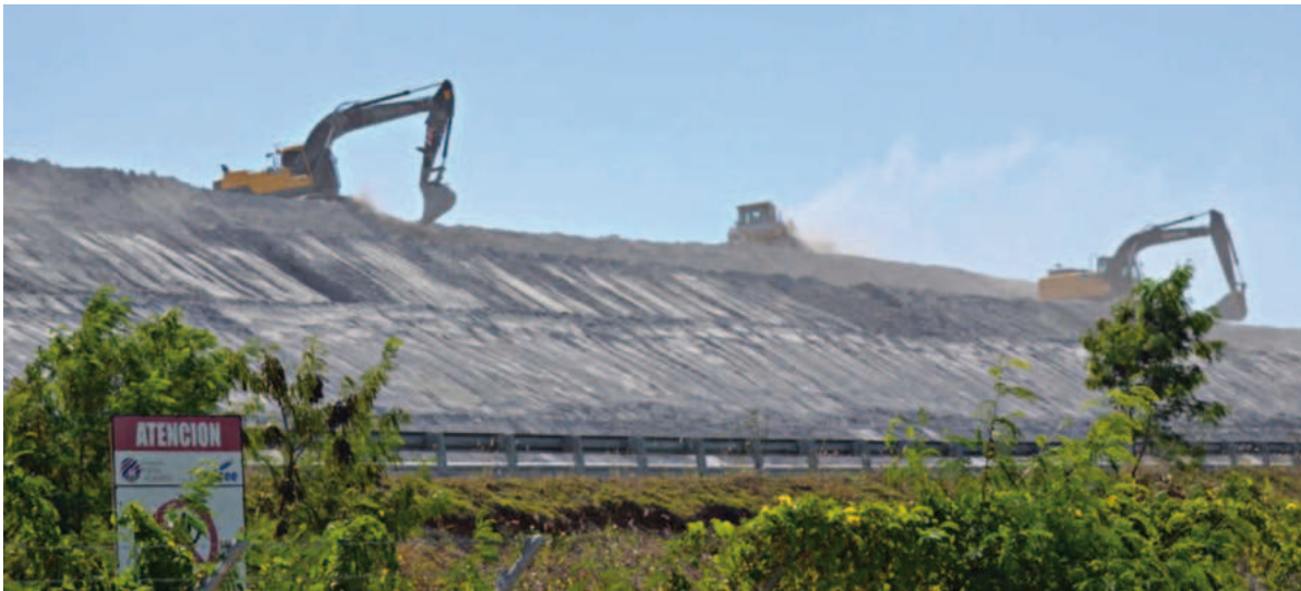
Montañas de cenizas tóxicas de la Central Termoeléctrica Punta Catalina. Batey San José, provincia Peravía. 12 de abril de 2021 © CLNCC
