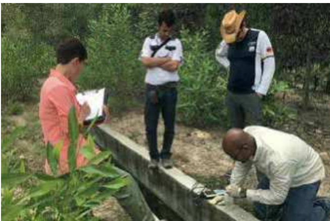
► PRCC. Planta de tratamiento de aguas residuales, Cocabel, Lempira, Honduras.
