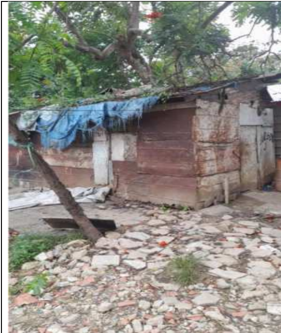
Foto 01: Vivienda ubicada en el barrio Los Casabes. Fuente: JGP Consultoría (mayo/2022).
