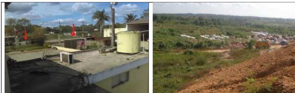
Foto 02: Vista cerca en fachada frontal del Vertedero.
