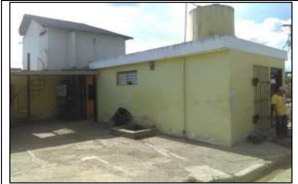
Foto 12: Vista cercana de Encargado de Transportación (a la derecha) y Caseta de Vigilancia (2do nivel).
