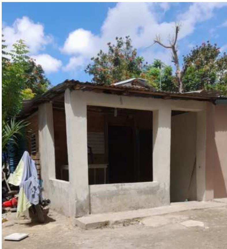
Imagen 4. Vivienda en el área de estudio con paredes de concreto. Fuente: propia.
