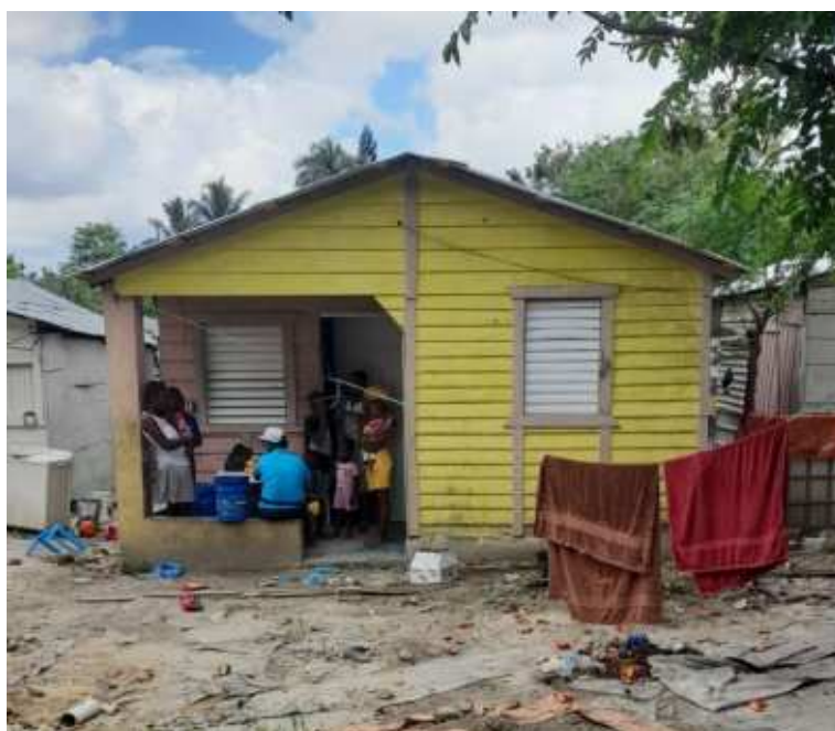
Imagen 1. Vivienda en el área de estudio con paredes de madera. Fuente: propia.
