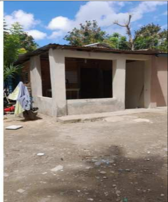
Foto 02: Vivienda ubicada en el barrio Los Casabes. Fuente: JGP Consultoría (mayo/2022).
