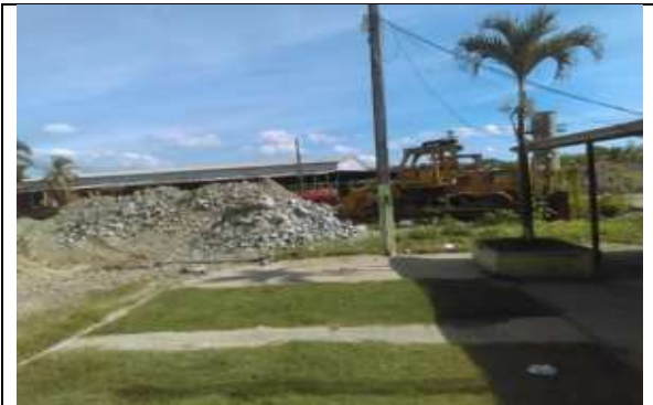
Foto 23: Vista área de aparcamiento de máquinas pesadas contigua al Edificio Comisión Administrativa, Área de peso y Encargado de Transportación.
