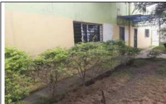
Foto 16: Vista lateral del Edificio Administrativo. Se observa ventanas y puertas de entrada a Comedor. Al final del pasillo se observa puerta al parqueo de empleados fuera de operaciones.
