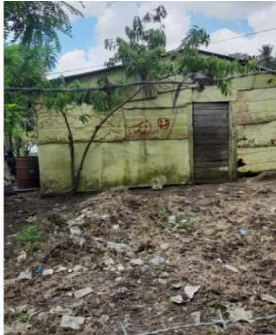
Foto 03: Vivienda ubicada en el barrio Los Casabes. Fuente: JGP Consultoría (mayo/2022).
