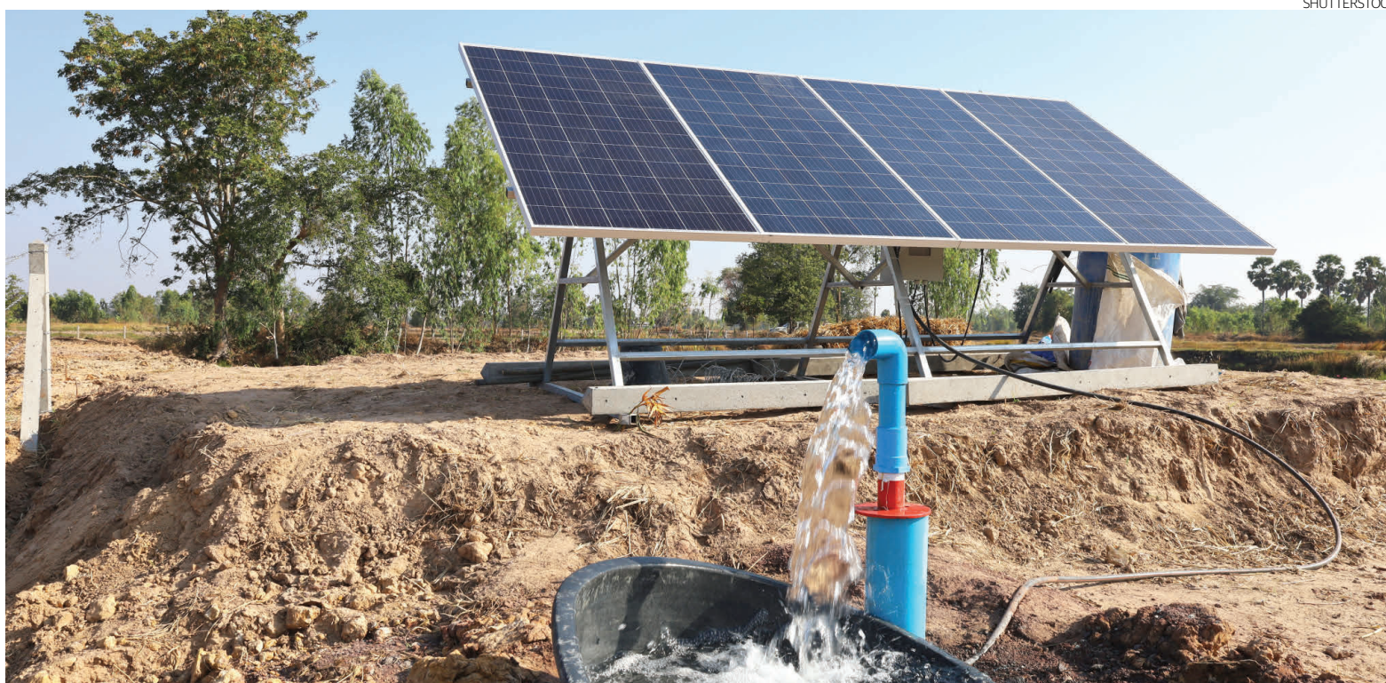
Imagen que ilustra el bombeo del agua a través del uso de paneles solares.
