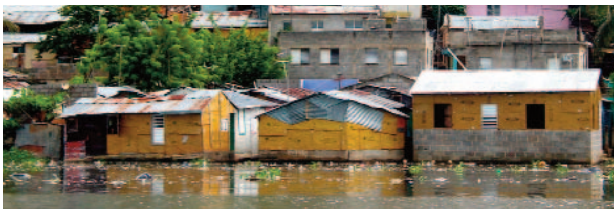
F-02 Margen Oriental Río Ozama (Santo Domingo Este)
