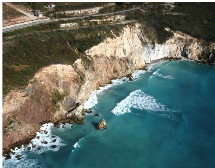
Erosión costera producto de la acción hidráulica en un alcantilado de la costa de Enriquillo.
