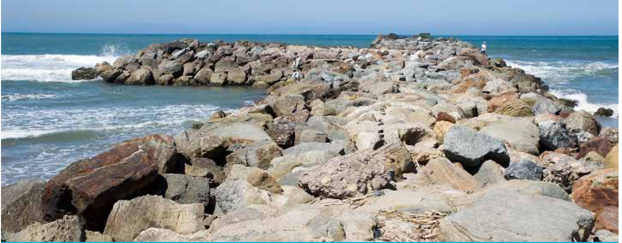
Los espigones producen una fuerte erosión de las playas
