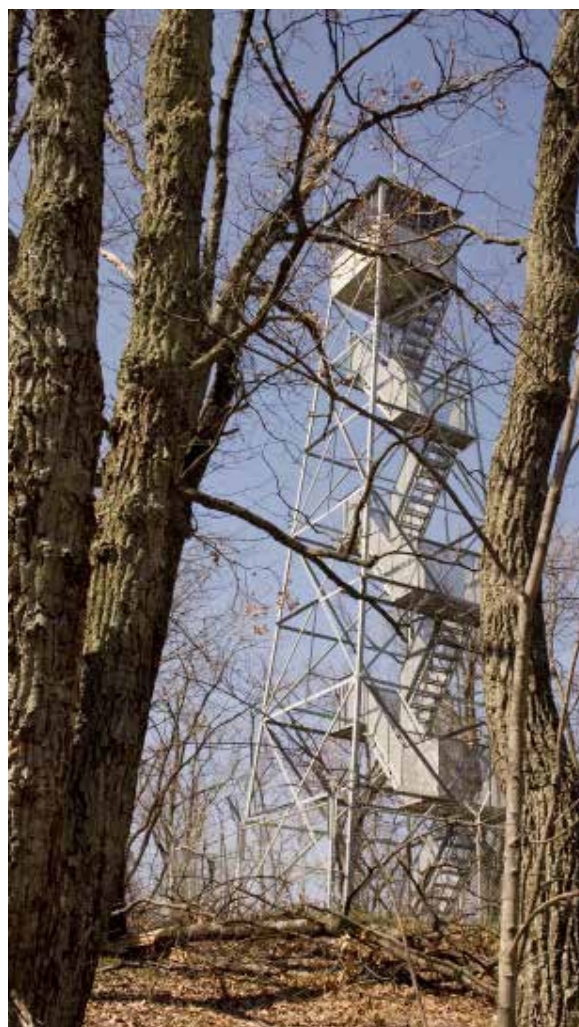
Casetas para la detección de incendios
