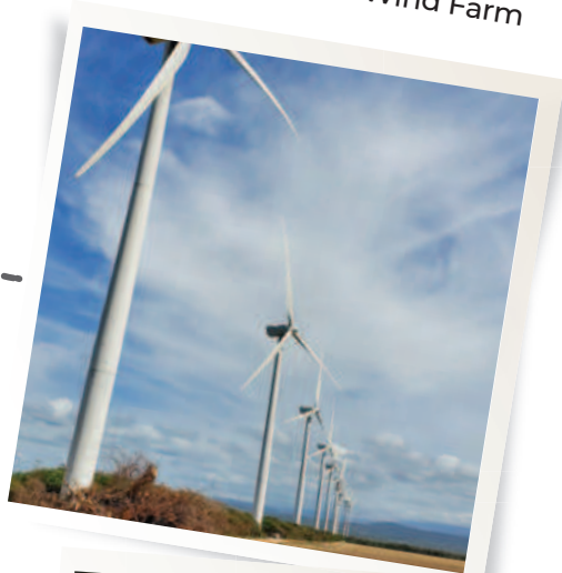
Parque Eólico Los Cocos Los Cocos Wind Farm
