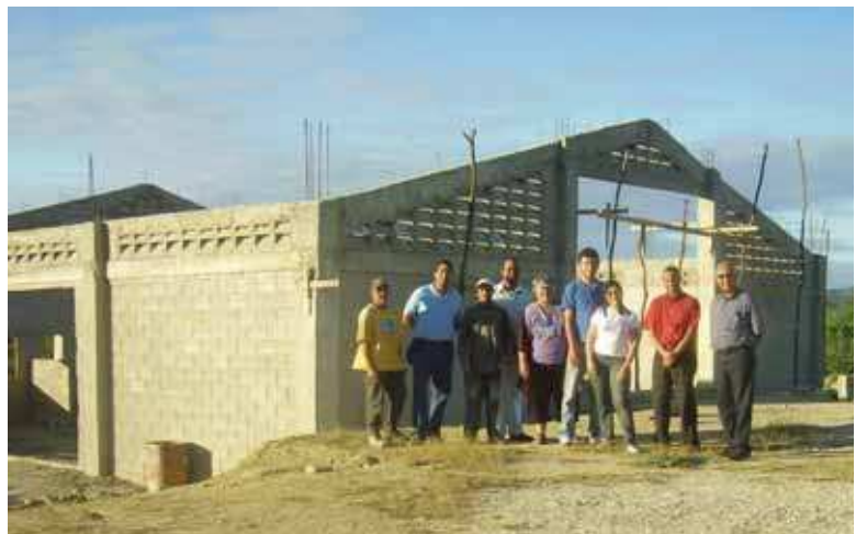
El Ingeniero Santiago Rivas supervisa la construcción del Centro de Acopio conjuntamente con los miembros de la Asociación de Apicultores "La Fronteriza".
