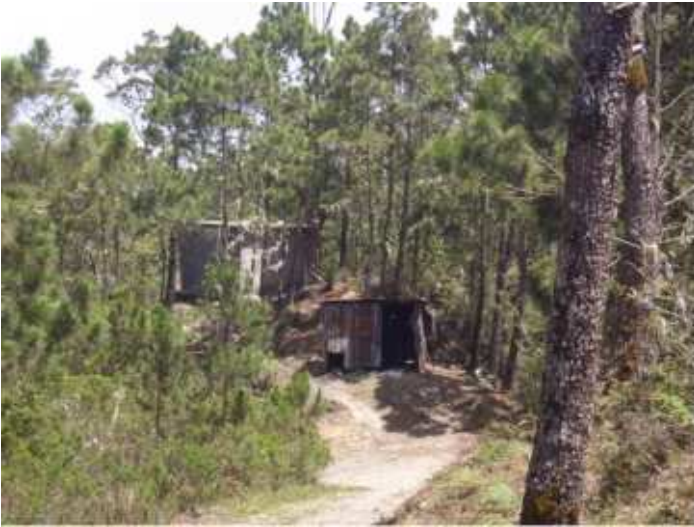
Figura 1. Casetas abandonadas. La caseta en primer plano alojaba el generador y la de atrás los equipos de transmisión.
