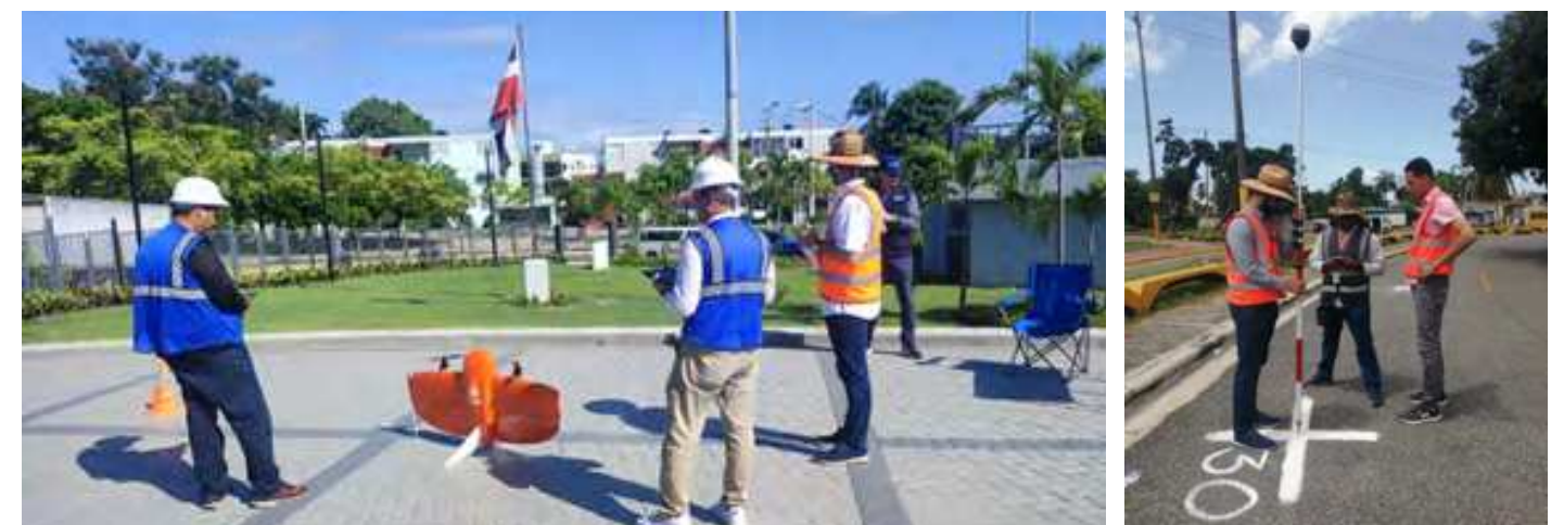
Fotografía. Proceso de levantamiento de información a partir de drones (izq.) y de comprobación de cotas (der.)
