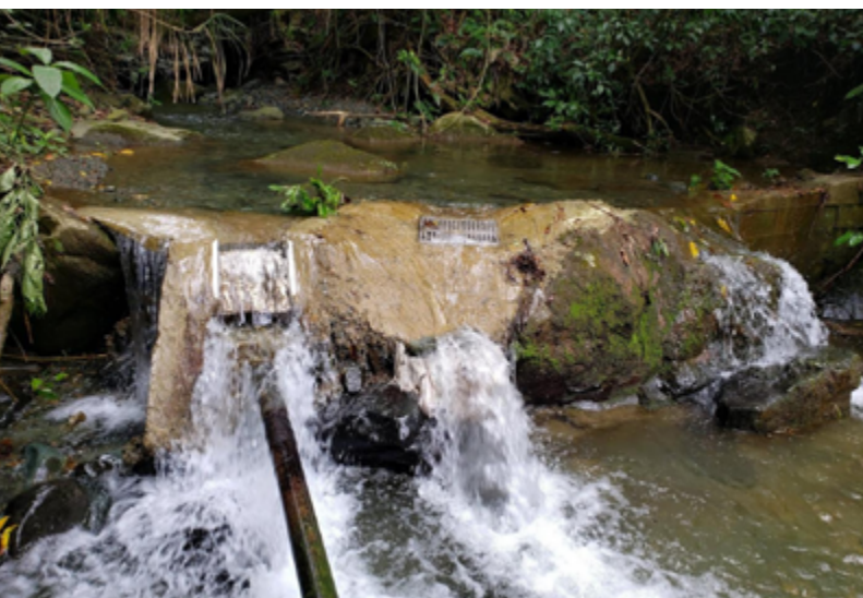
Ilustración 13: ejemplo de captación superficial en el acueducto por gravedad de Las Piedras, en San José de las Matas. Fuente: SIASAR.
