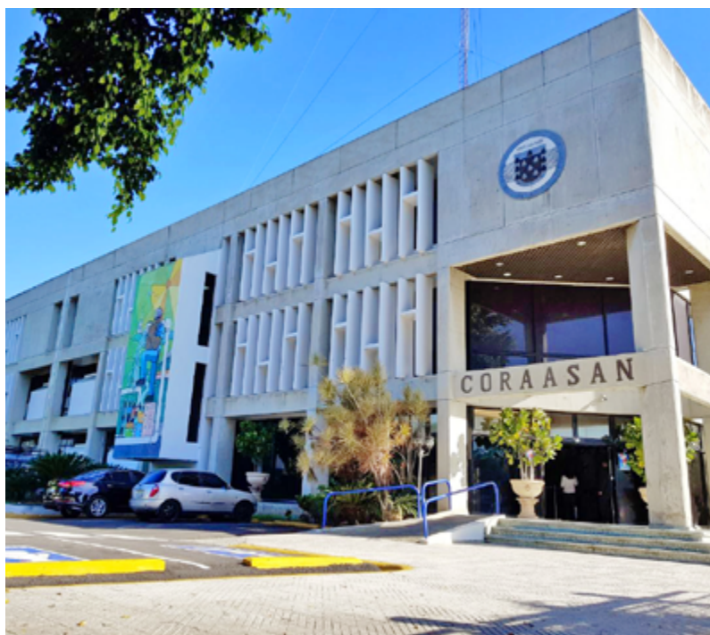
Ilustración 2: edificio administrativo de CORAASAN, en Santiago de los Caballeros. Fuente: CORAASAN.
