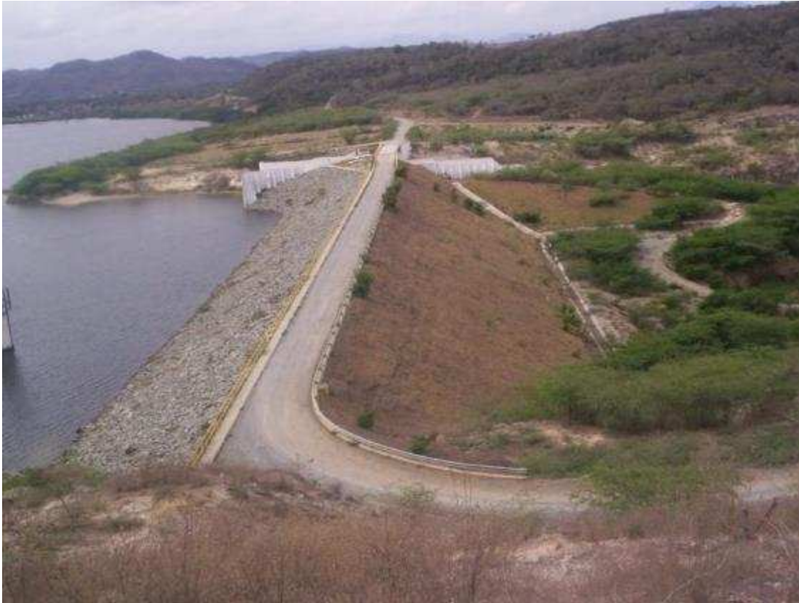
Figura 6. Una vista del dique de la presa de Maguaca, en la Cuenca Yaquá del Norte.
