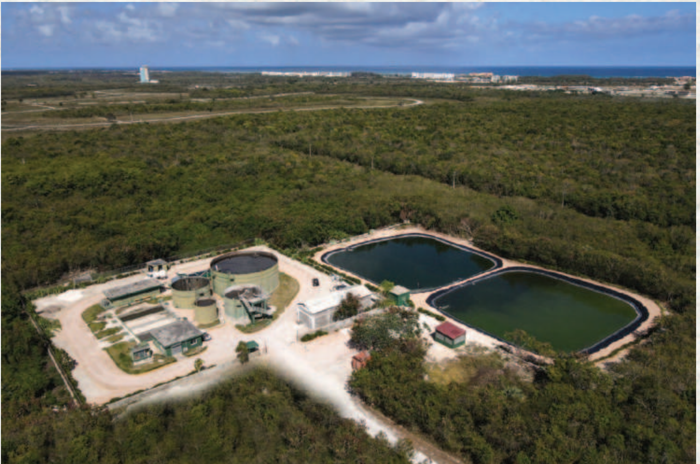
A través de la planta de tratamiento de aguas residuales de Cap Cana , el 100 % de las aguas residuales generadas dentro de Cap Cana son reutilizadas y aprovechadas para el riego del campo de golf y las áreas verdes.
