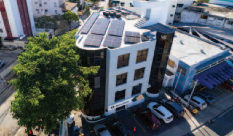
Paneles solares en los techos de nuestras oficinas administrativas y sucursales.
