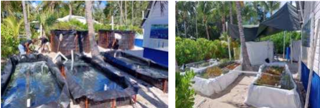
Imágenes 1 y 2. Proceso de construcción e instalación de sistema acuapónico.
