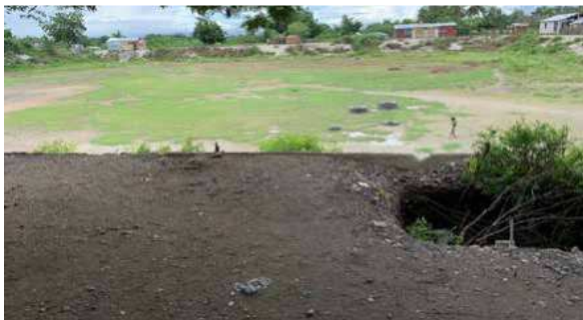
Antigua laguna de oxidación.
