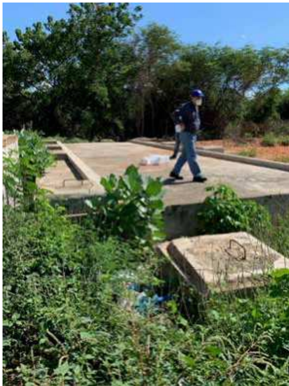
Urbanización Villa Progreso: Sistema De Tratamiento UASD.
