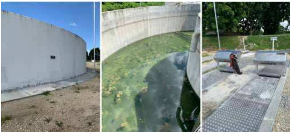
Aireación: tanque biológico / Tanque de sedimentación / Desinfección: rayos ultravioletas.
