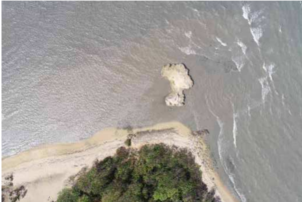
Ilustración 2: Fotografía en Punta Cafemba en julio 2020 con trabajos de construcción ya iniciados en el puerto.
