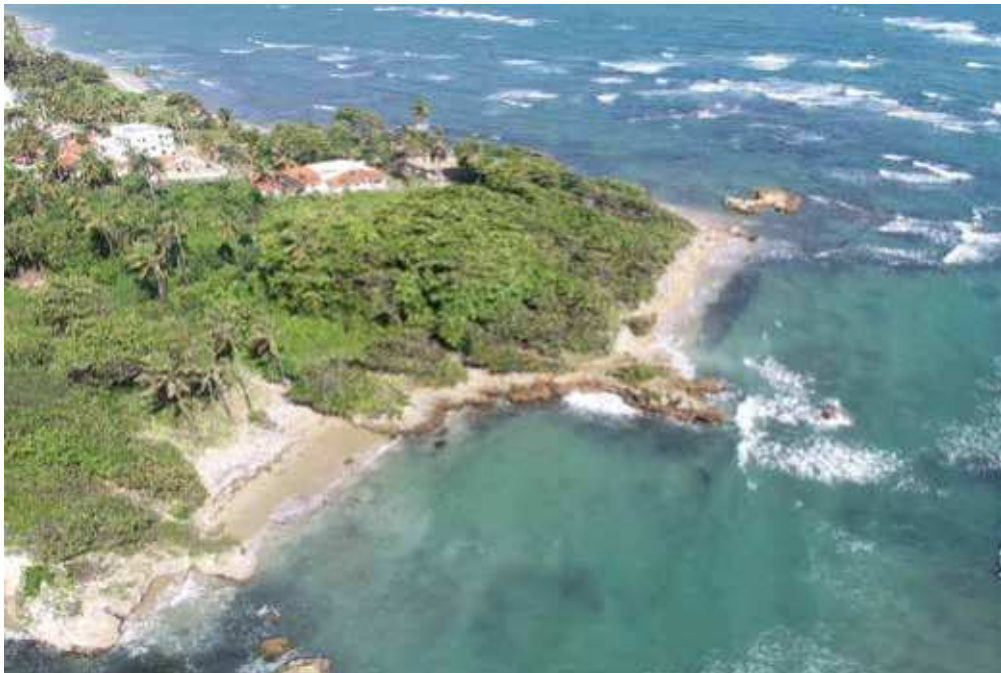
Ilustración 1: Fotografía en Punta Cafemba en enero, previo a inicios de trabajos de construcción de puerto.
