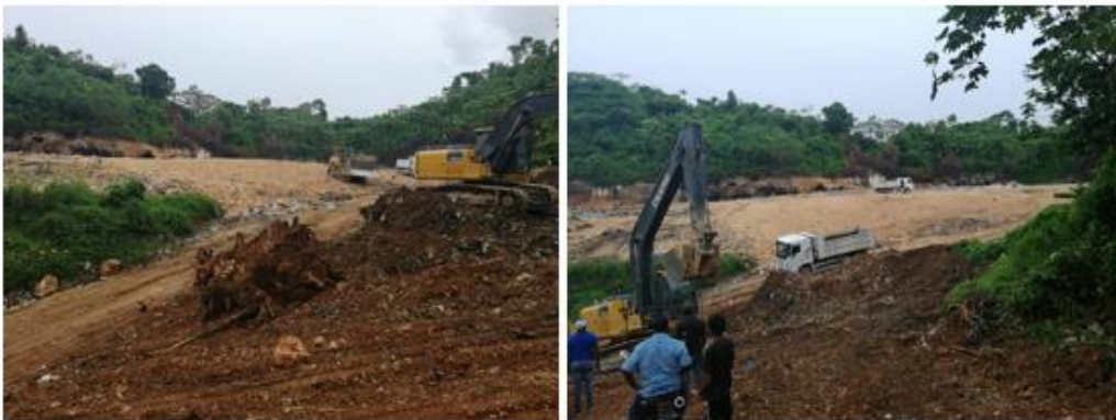
Trabajos después de la intervención Vertedero de Las Terrenas
