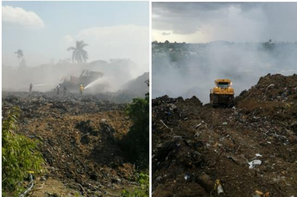
Trabajos antes de la intervención Vertedero de Moca
