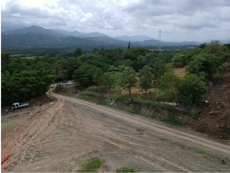
Trabajos en el Vertedero de Villa Altagracia
