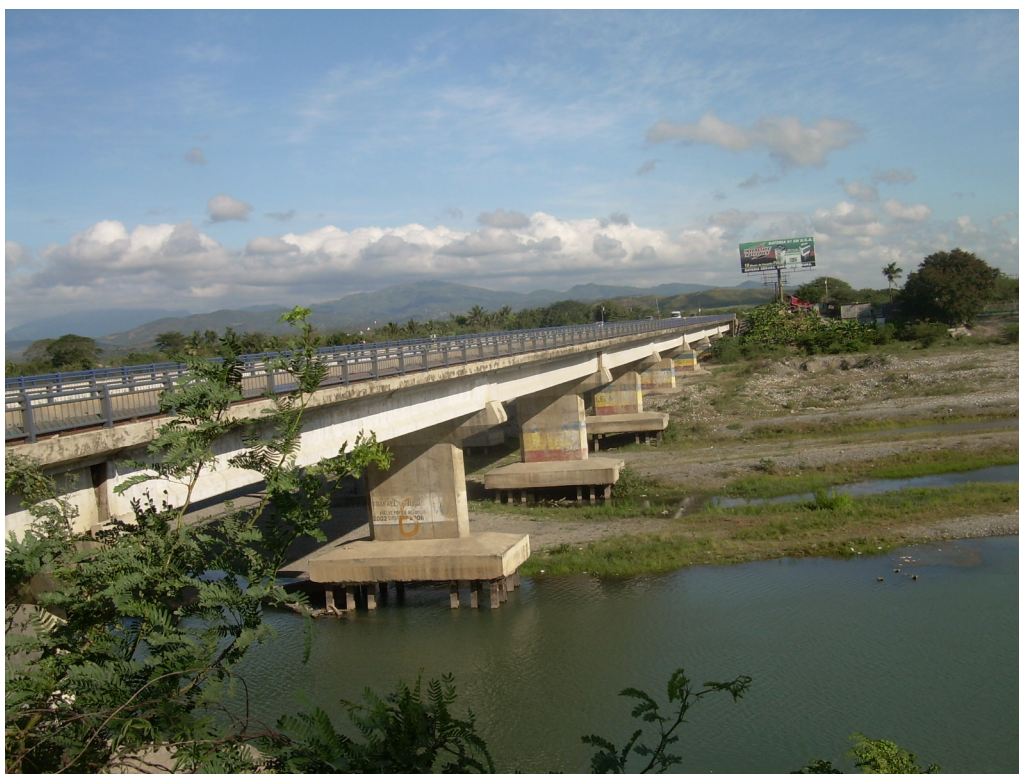
Foto 1.- Vista parcial del Río Nizao en el Puente de Lucas Díaz
