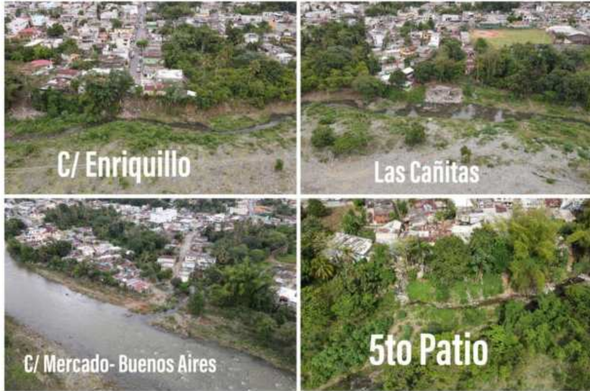
Zonas de riesgos a la orilla de Rio Haina
