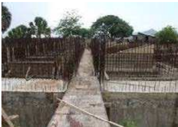
Construcción Planta de Agua Potable de Partido
