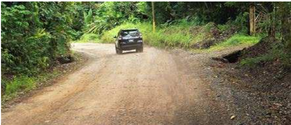
Calle sin asfaltado
