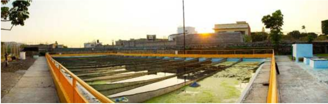
Laguna de estabilización de las instalaciones del IMTA. © IMTA.
