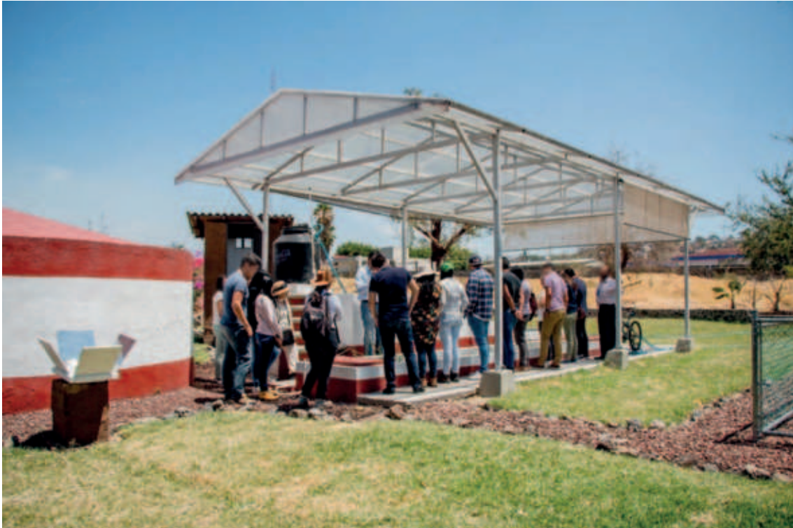
Humedal artificial, Tecnologías apropiadas del IMTA “Casa Ecológica Rural”. © IMTA.
