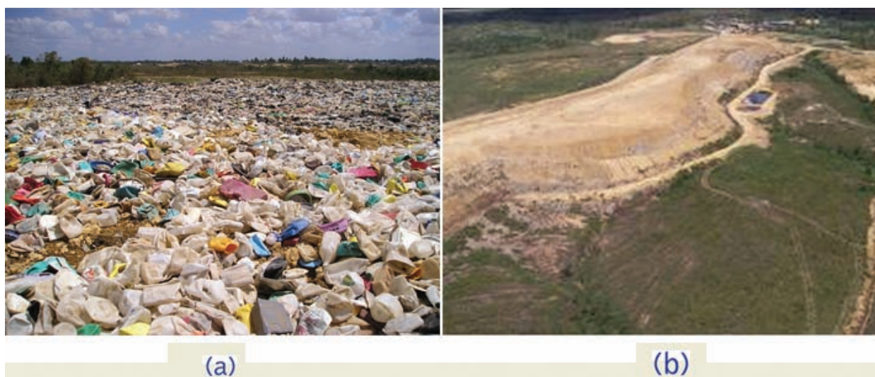
Foto 1. Relleno controlado de Duquesa (a) situación en 2004, (b) situación en 2009, Santo Domingo Norte.
