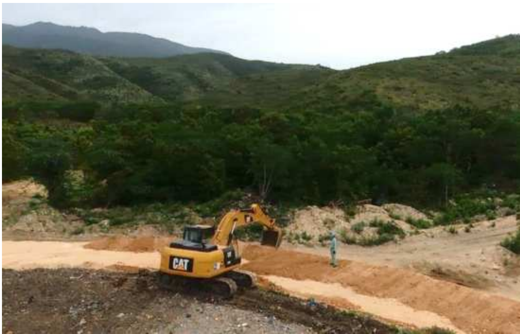
Foto 2: Proceso de instalación de un dique de terraplén para una celda.
