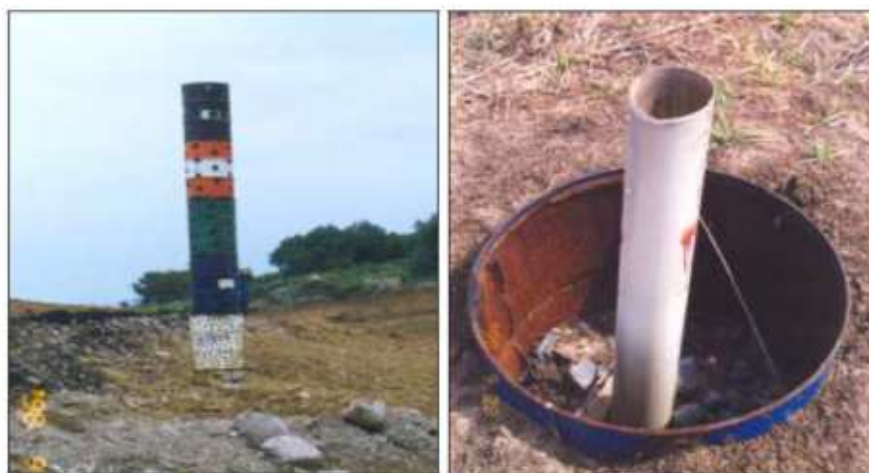
Figura 13: Ejemplo de una instalación sencilla para ventilación de gases
