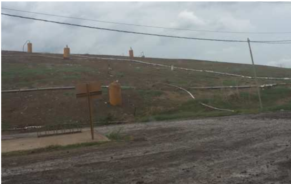
Figura 11: Vista cobertura final y capa vegetal en un relleno
