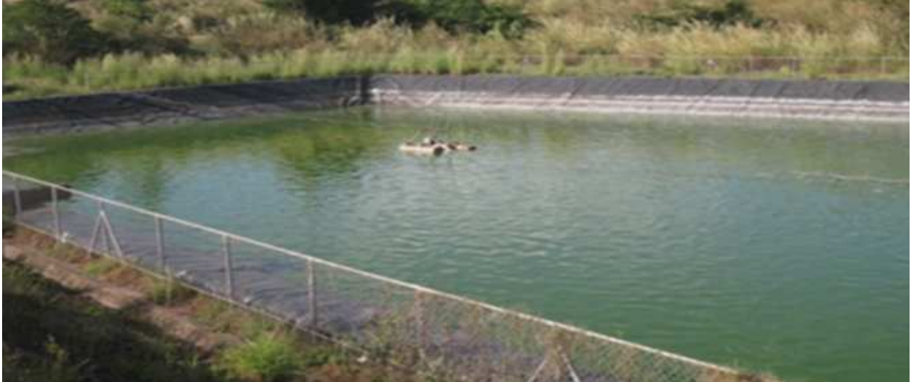
Foto 5: Laguna de lixiviados en el Relleno Sanitario de ASINORLU, Santa Rosa de Lima, El Salvador
