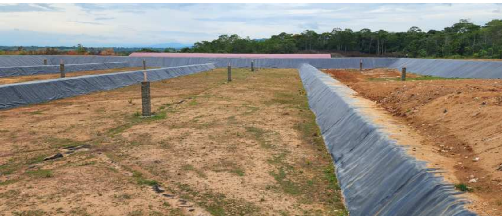
Fuente: Equipo de expertos de JICA Foto 1: Relleno Sanitario Tarapoto, Perú
