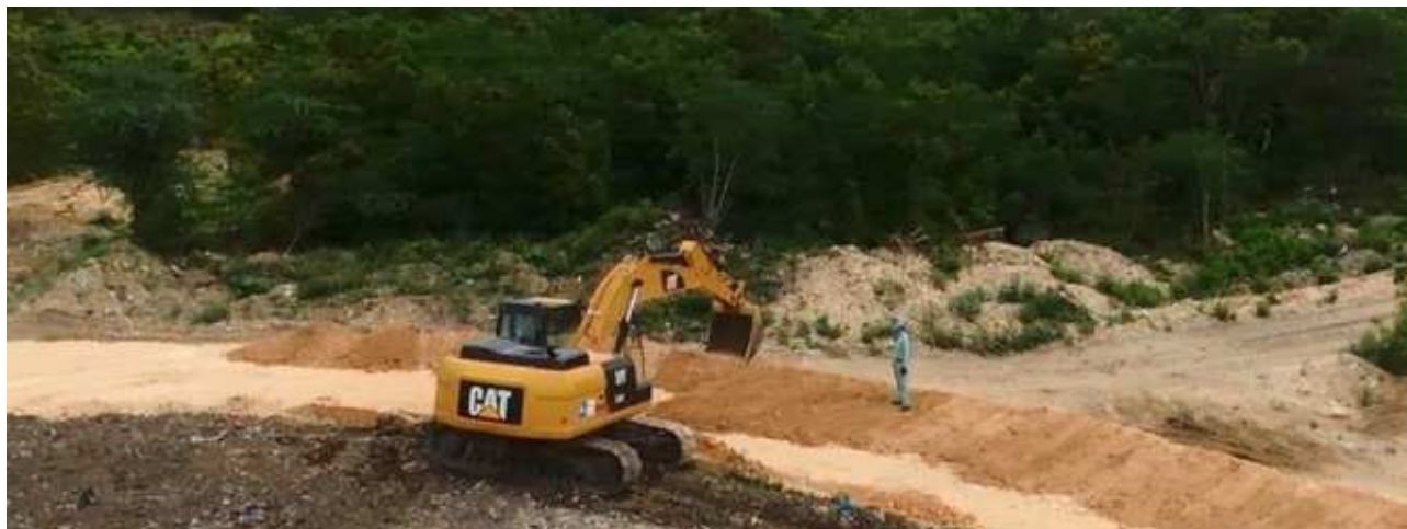
Foto 4: Proceso de instalación de un dique de terraplén para una celda. -
