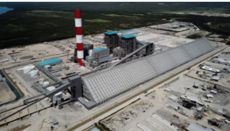
Termoeléctrica a carbón Punta Catalina. Fuente: Cdeee.
