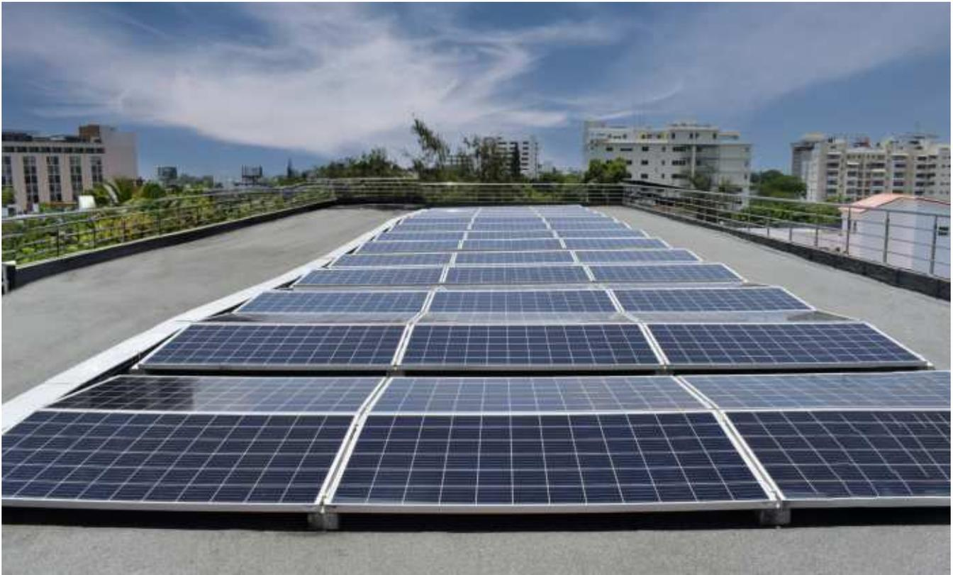
Infraestructura de generación de energía renovable con potencia nominal instalada de 80.14 KWp. Fuente: autores.
