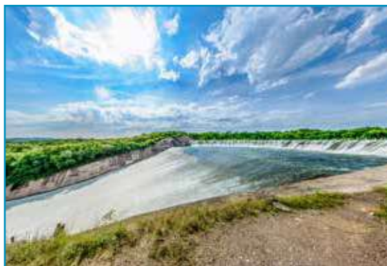
Planta hidroeléctrica de Sanalona, Sinaloa.
