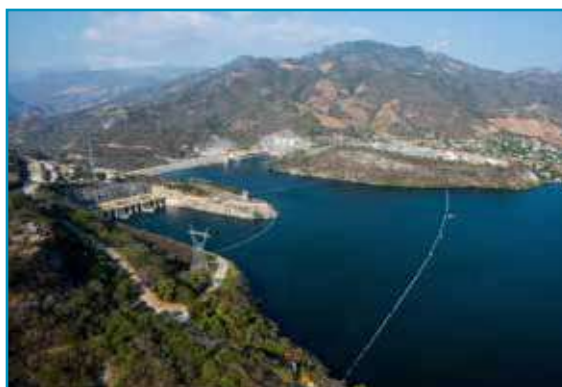
Planta hidroeléctrica de Chicoasén, Chiapas.
