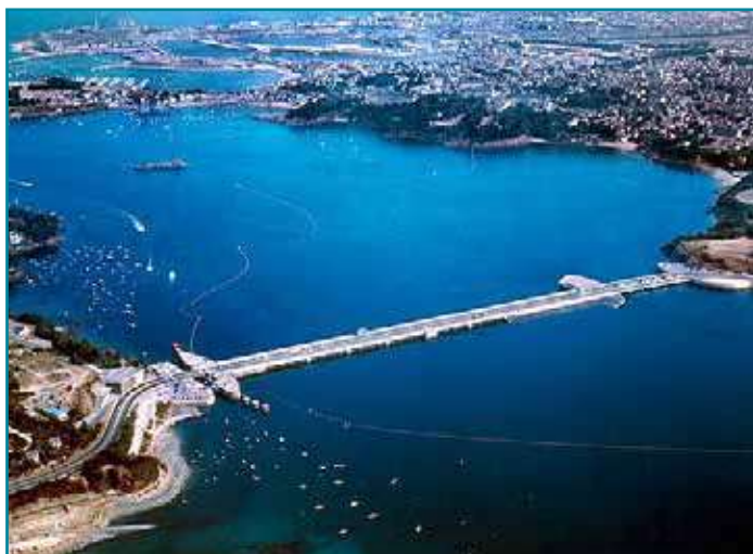
Figura 6. Central maremotriz de 240 MW. La Rance, Francia
