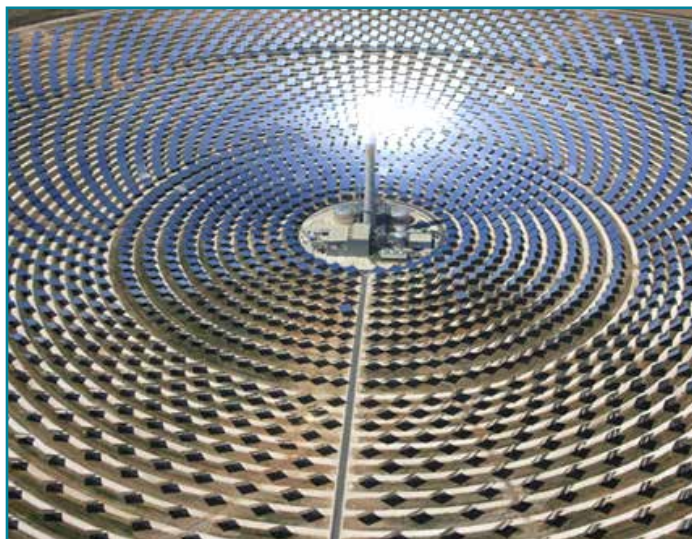
Figura 4. Planta de energía solar por concentración, Gemasolar. Torre Central. Sevilla, España
