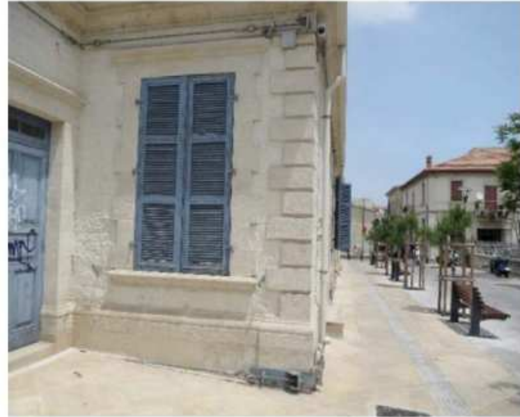
MEDIDAS DE REFUERZO ESTRUCTURAL PARA DAÑOS SÍSMICOS: TENSORES DE HIERRO
