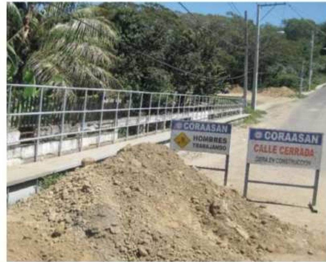
FIGURA 129. OBRA DE IMPULSIÓN DE LA ESAR ARROYO HONDO
