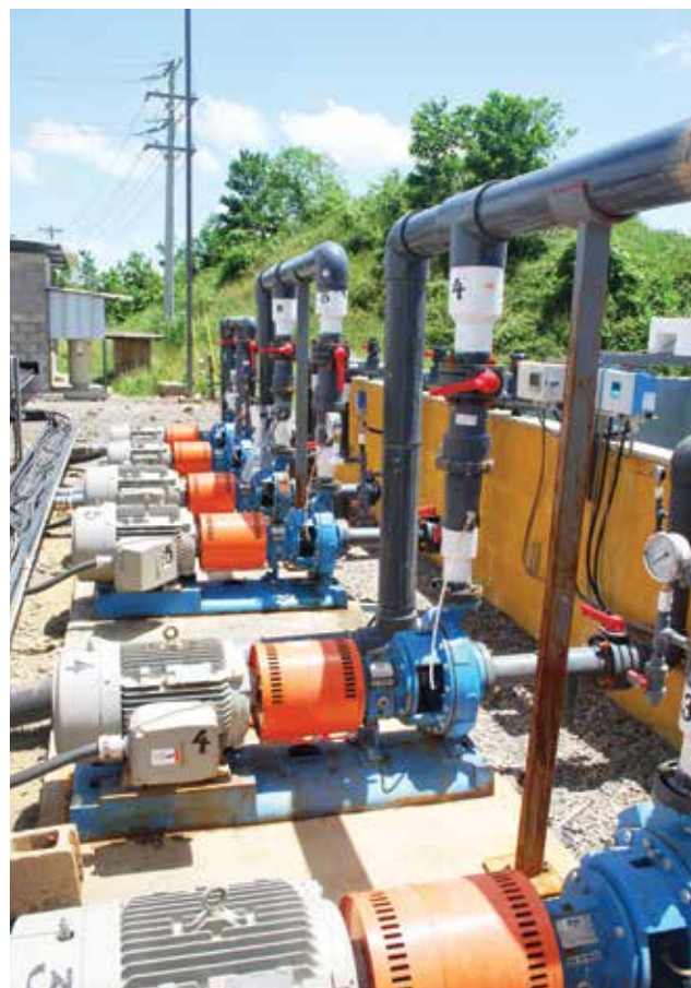
Área de Bombeo en empresa, una fuente frecuente de ruido industrial.
