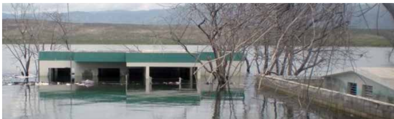
Oficinas de Agricultura fronteriza, inundadas por la crecida del lago Sumatra, al oeste de Jimaní (Sept 2010). Note que en la foto de arriba hay seis líneas de blocks a la derecha y en la foto de abajo solo hay tres.
