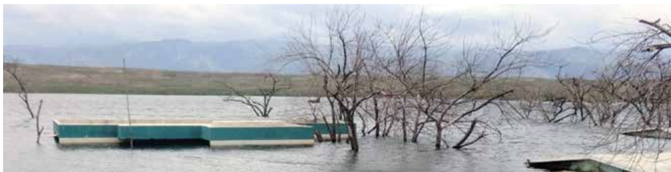
Oficinas de Agricultura fronteriza, inundadas por la crecida del lago Sumatra, al oeste de Jimaní (Julio 2011).
