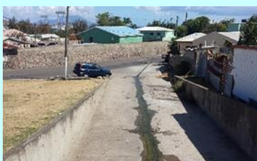
El agua gris fluye a través de canales abiertos en la calle
