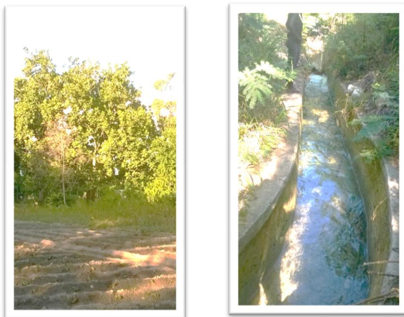
Imagem 3. Sistema de irrigação por canaletas. A. Sistema de irrigação por canaletas em Anse-à-Pitre (esquerda); B. Canal de distribuição de água em Anse-à-Pitre (direita).
