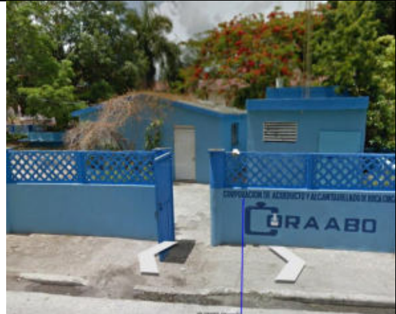
Foto 02: Actual EB, a ser mejorada para la EDB-02 del Proyecto Boca Chica. Google Street view.
