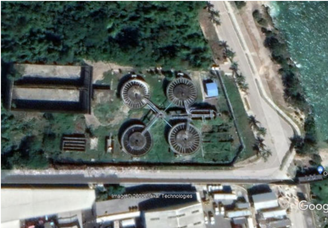
Figura 3.2.1.a Vista de la PTAR existente
