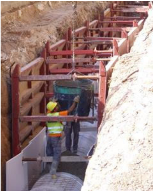
Figura 7.1.b Ejemplo de entibado de zanjas
