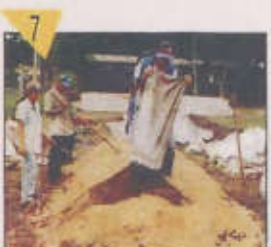
7 Coloque una capa de 5 qq de tierra, también humedeciéndola.
