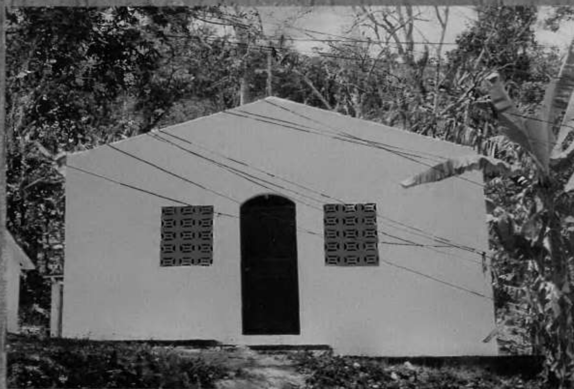
Iglesia de la comunidad de la Yañita, construida con recursos del Plan Nacional "Quilameya Verde".
