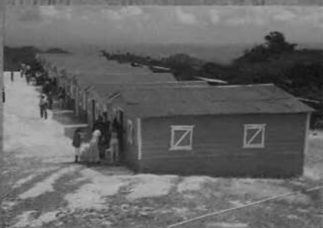
25 viviendas nuevas construidas en apoyo del Plan Nacional Quisqueya Verde en este paraje. En este paraje también fue edificada una escuela comunal.
