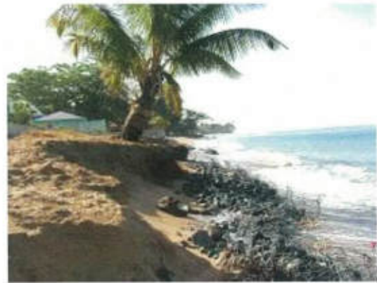
Gaviones corroídos en el balneario de Rincón, Puerto Rico (izquierda). Piedras sueltas y restos de alambre en la playa (derecha). Estos gaviones fueron eventualmente reemplazados por un muro.
