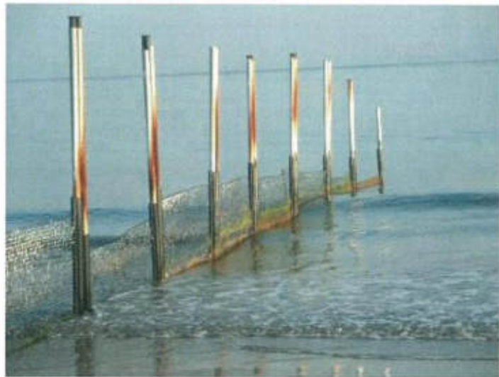
Espigones permeables están siendo evaluados en Carolina, Puerto Rico, mayo 2007.
