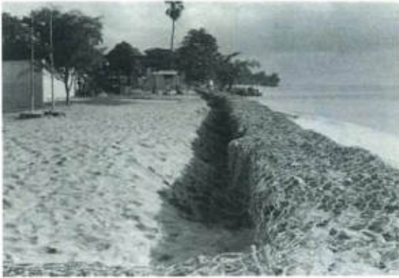
Gaviones corroídos en el balneario de Rincón, Puerto Rico (izquierda). Piedras sueltas y restos de alambre en la playa (derecha). Estos gaviones fueron eventualmente reemplazados por un muro.
