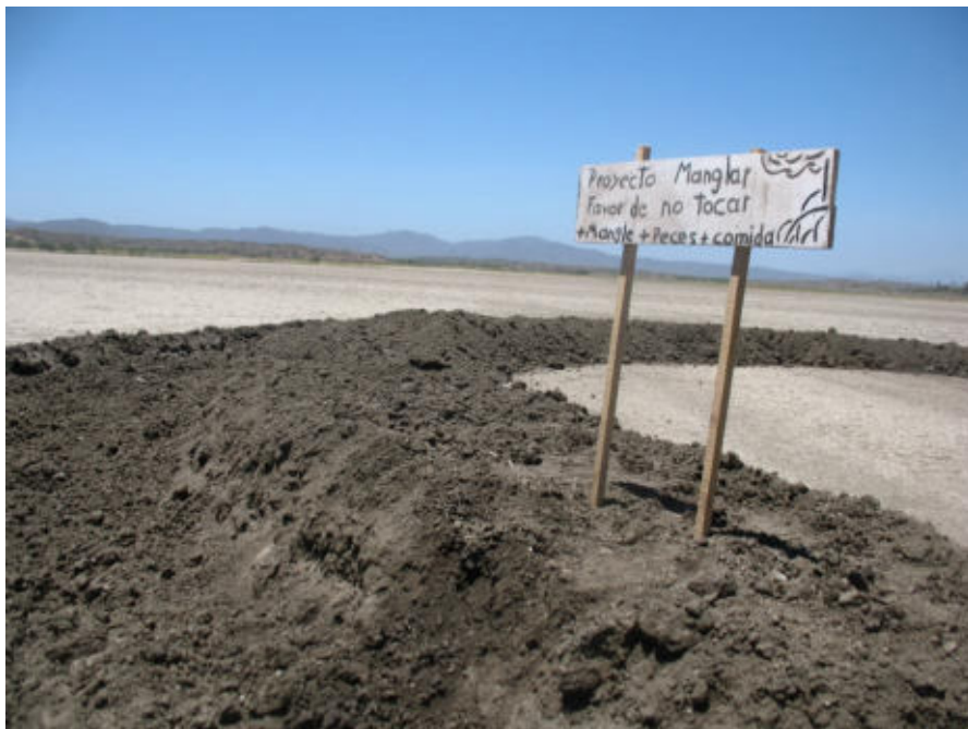
Foto 17. Terraza en forma de Herradura con su canal perimetral en la parte externa.
