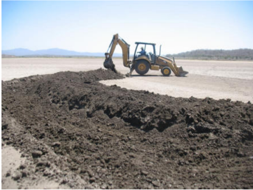
Foto 16. Inicio de la construcción de la terraza en forma de herradura (canal perimetral externo).
