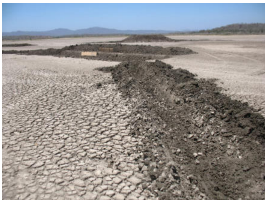
Foto 19. Canal de intercomunicación entre las terrazas y con una vena de mareas.
