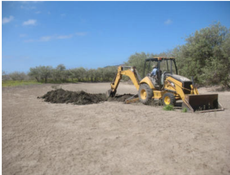
Foto 14. Retroexcavadora en proceso de construcción de una terrazas.
