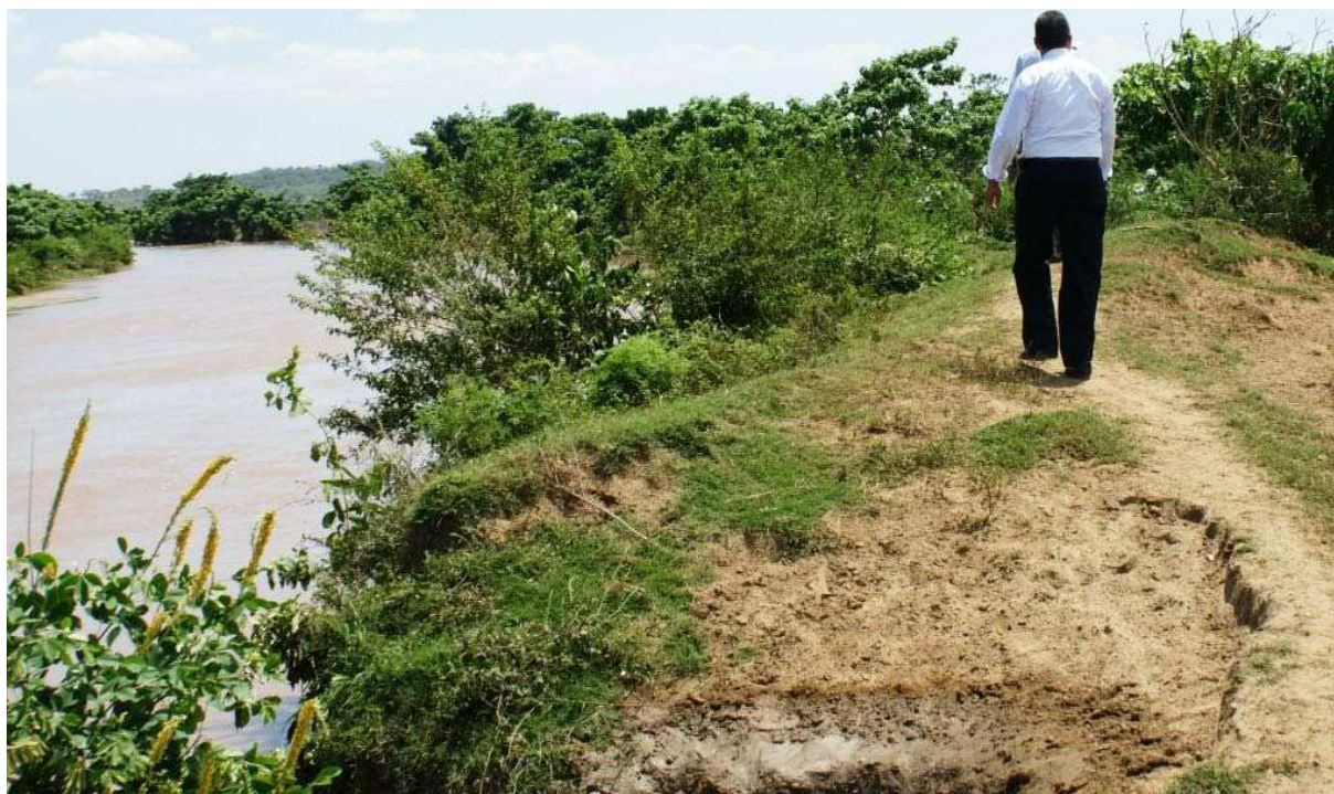
Muro de tierra que evita desbordamiento del Masacre en su cuenca baja.
