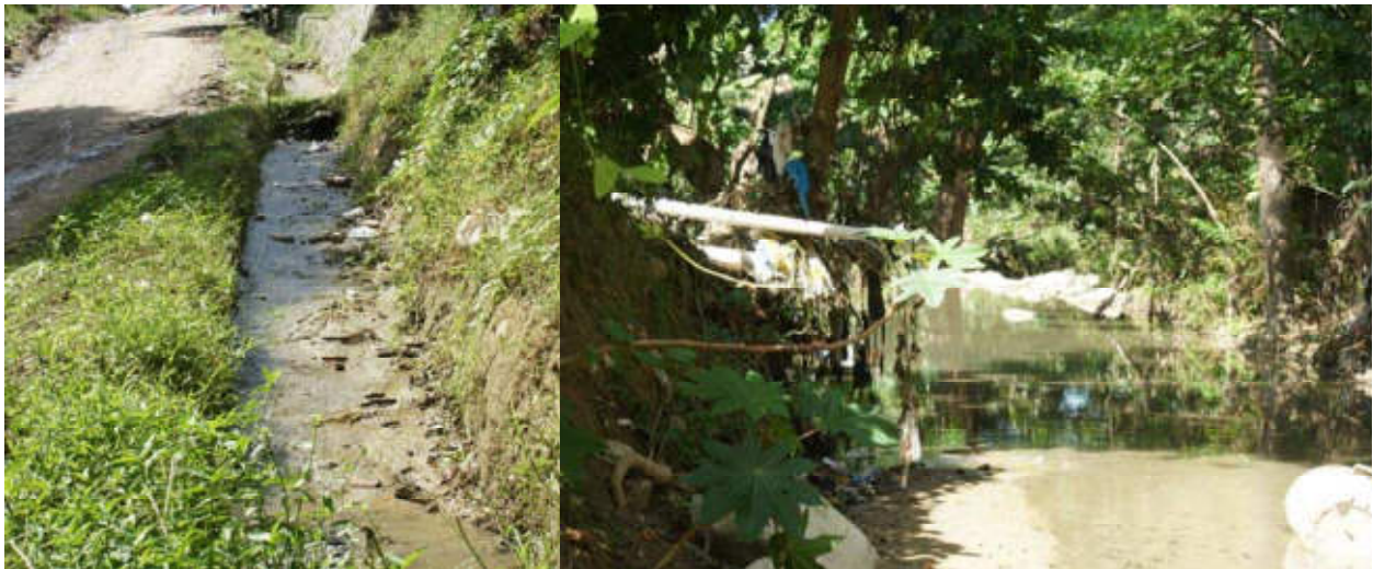
Foto 12. Izquierda. Desagüe pluvial contaminado de los Sectores El Mingo y Barraco del Municipio Comendador, que llega al Río Comendador. Derecha. Descarga por tubos de aguas residuales de las viviendas ubicadas en los márgenes del Río Comendador.
