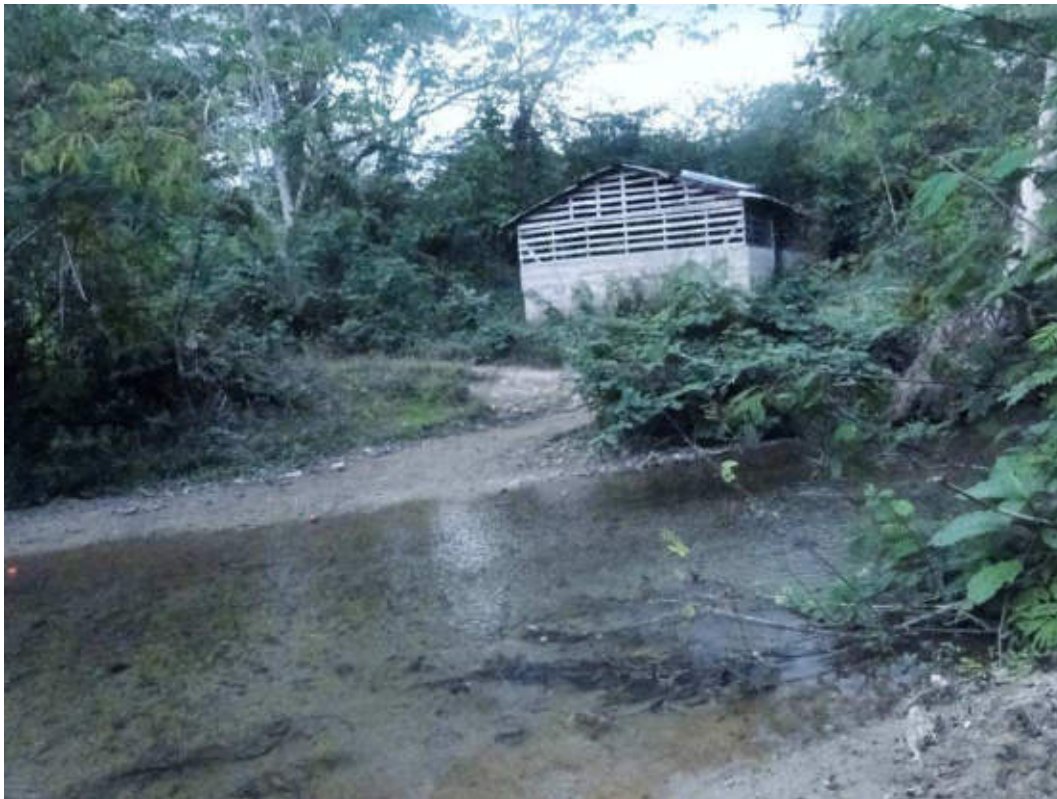
Foto 6. Vista del matadero de Río Limpio.
