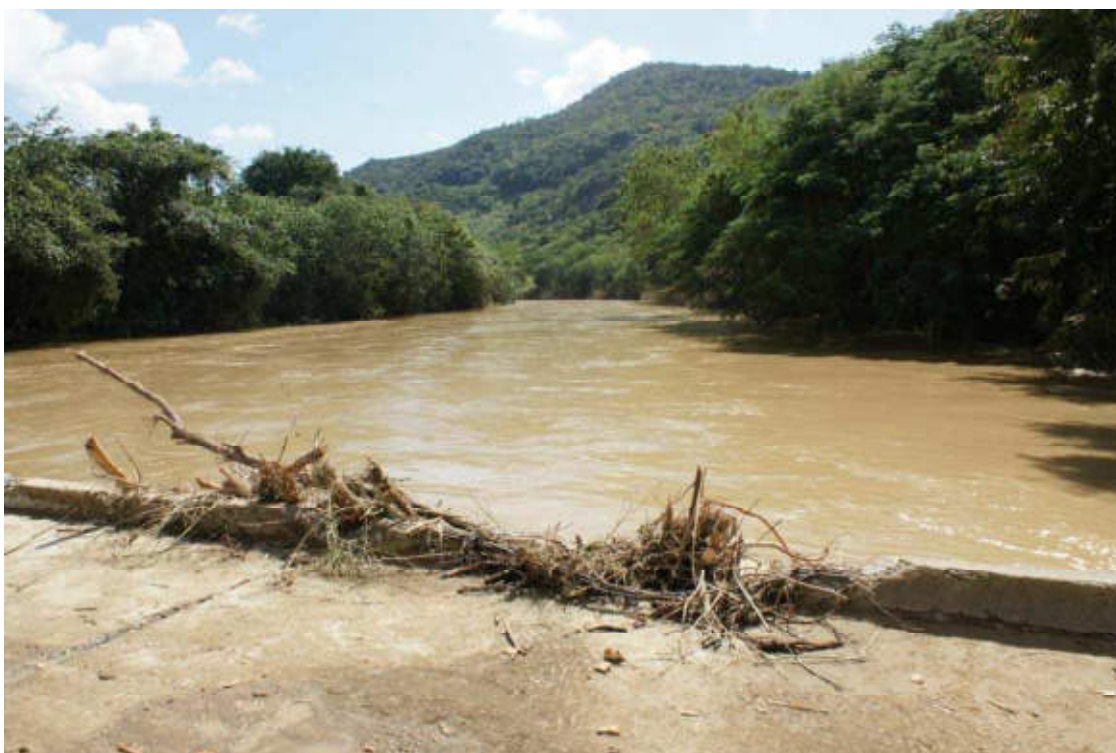
Foto 8. Vista del Río Artibonito desde el puente sobre el río en Pedro Santana, donde se observa la alta carga de sedimentos que arrastra.
